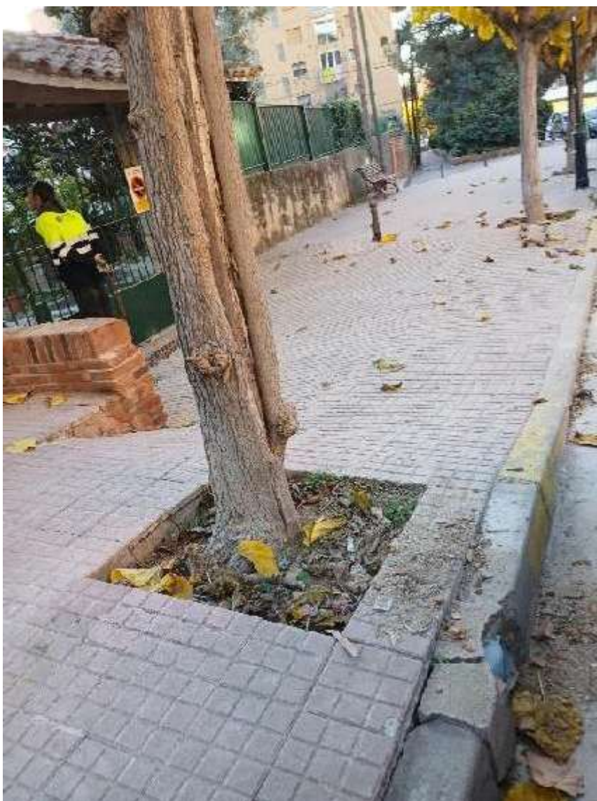
FOTOGRAFIA 1 _imatge general de la vorera de la Riera de Torrentbó (Riera de Caldetes), davant del núm. 114 , on s'observa el lloc dels fets.
