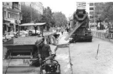
VERTIDO DE HORMIGÓN DE FIRME
