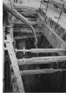
VERTIDO DE HORMIGÓN DE RECUBRIMIENTO
