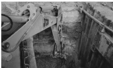
DEMOLICIÓN MECÁNICA EN ZANJA
