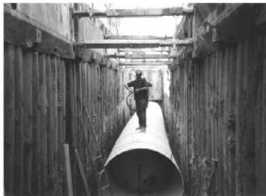
COLOCACIÓN TUBERÍA DE PVC. (RIB-LOC)
