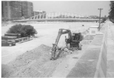
DEMOLICIÓN MECÁNICA A CIELO ABIERTO
