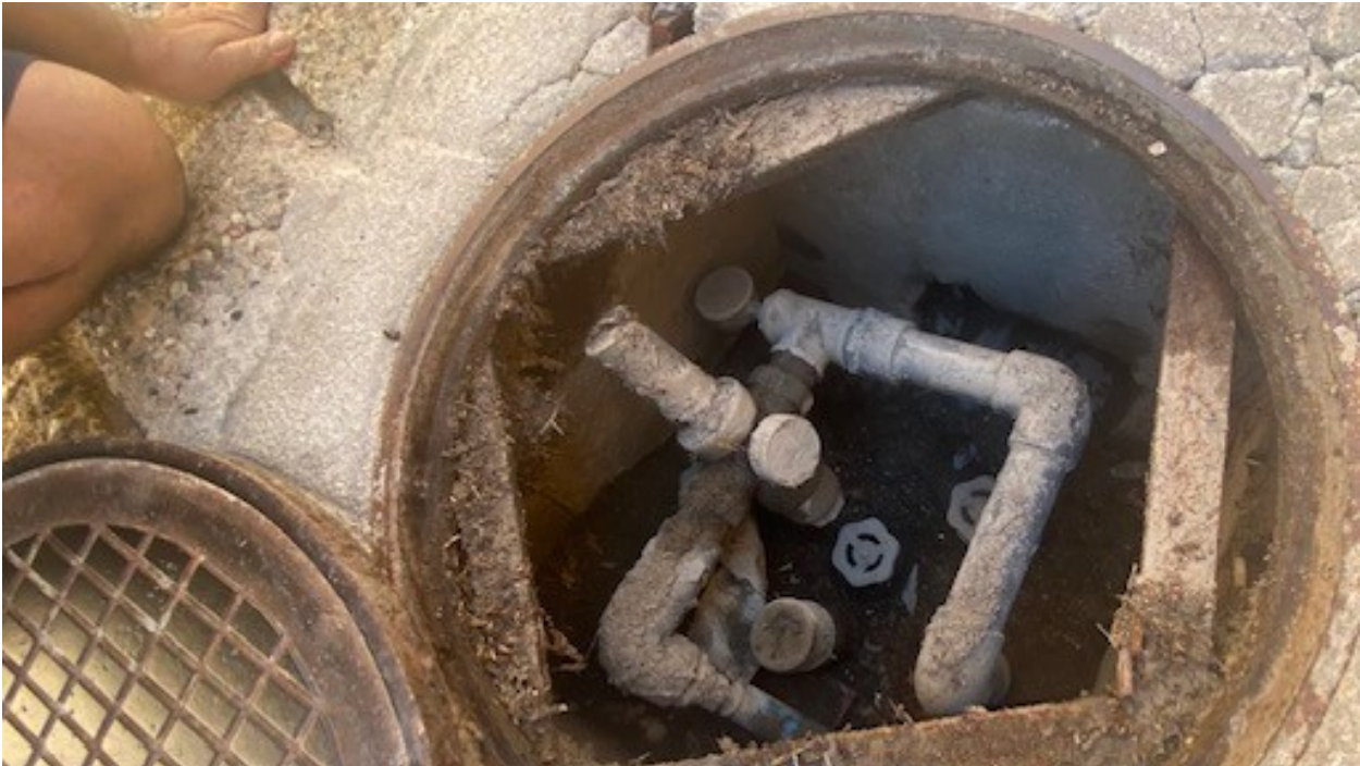
BUNERA EXISTENT FINAL CARRER MAJOR -MANOMETRE-BYPASS-VALVULA REDUCCIÓ
