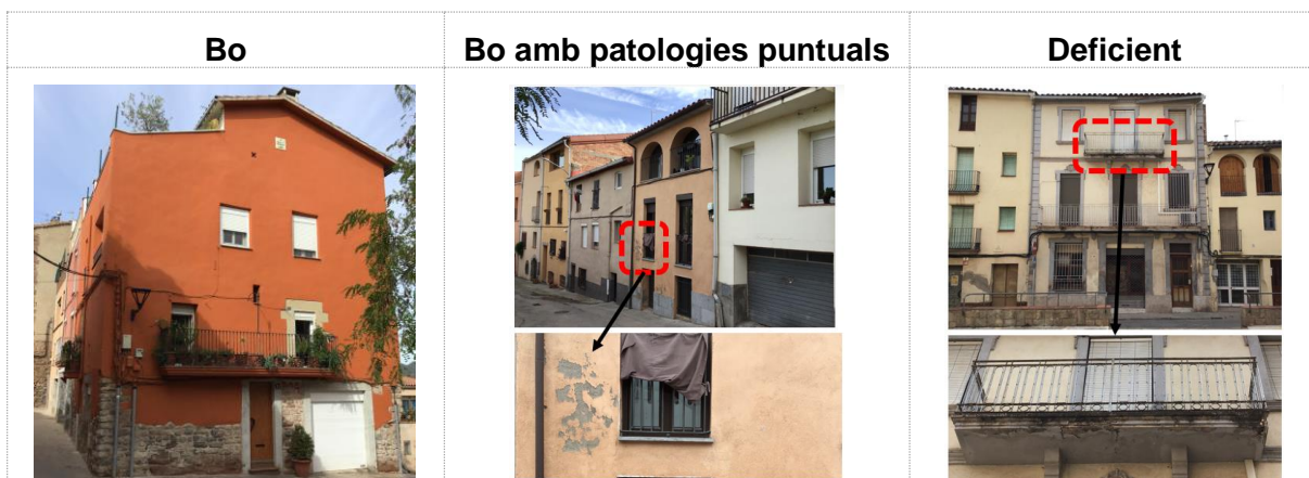
Figura 4. Exemples d'estat de façana.
