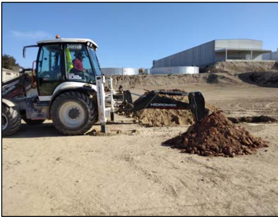
Fotografia 1 i 2. Detall de la màquina utilitzada per a la realització de les cales i obertura d'una de les cales realitzades.
