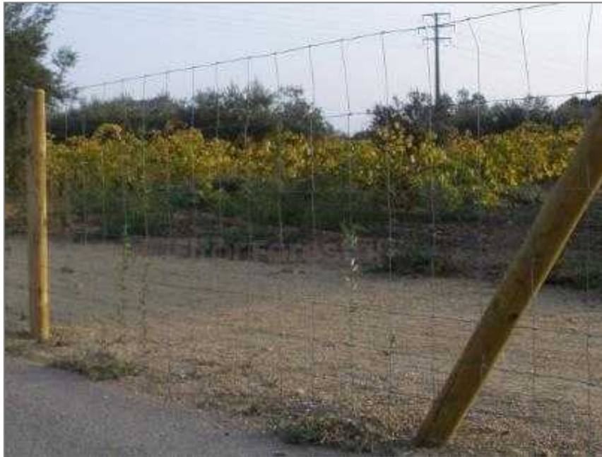
Fotografia 4. Mostra de malla cinètica i suports per a la tanca perimetral.
