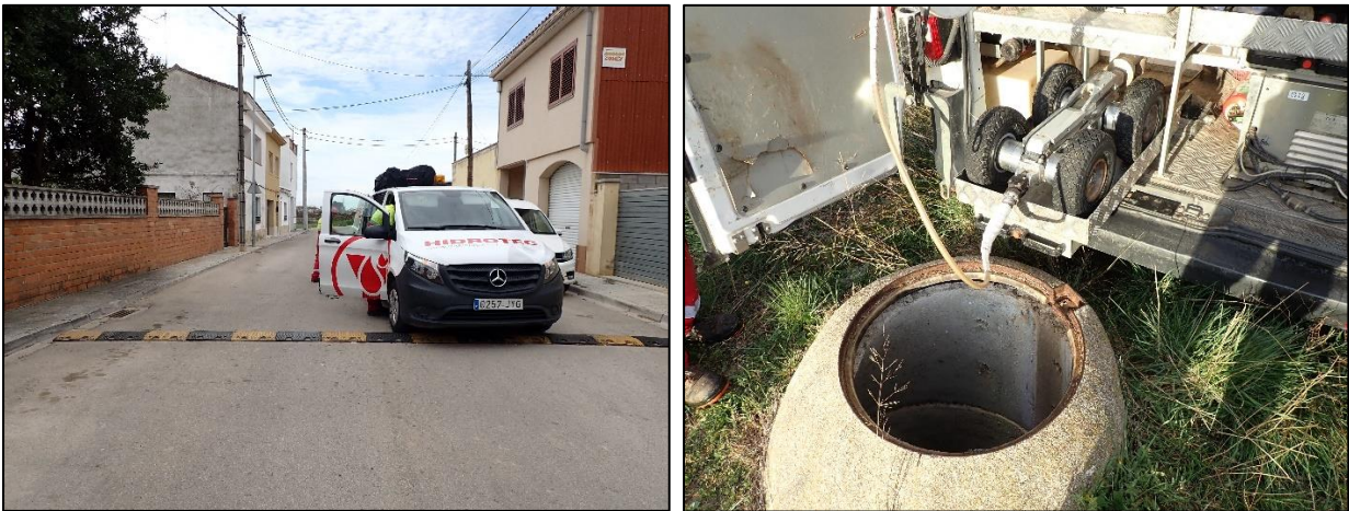
Figura 15. Inspecció amb càmera CCTV. Municipi de Sant Cugat Ssegarrigues.
