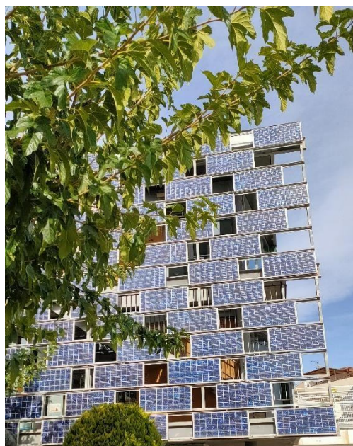
Figura 27. Detall de la façana del volum D on hi ha instal·lats els panells solars. Elaboració pròpia.
