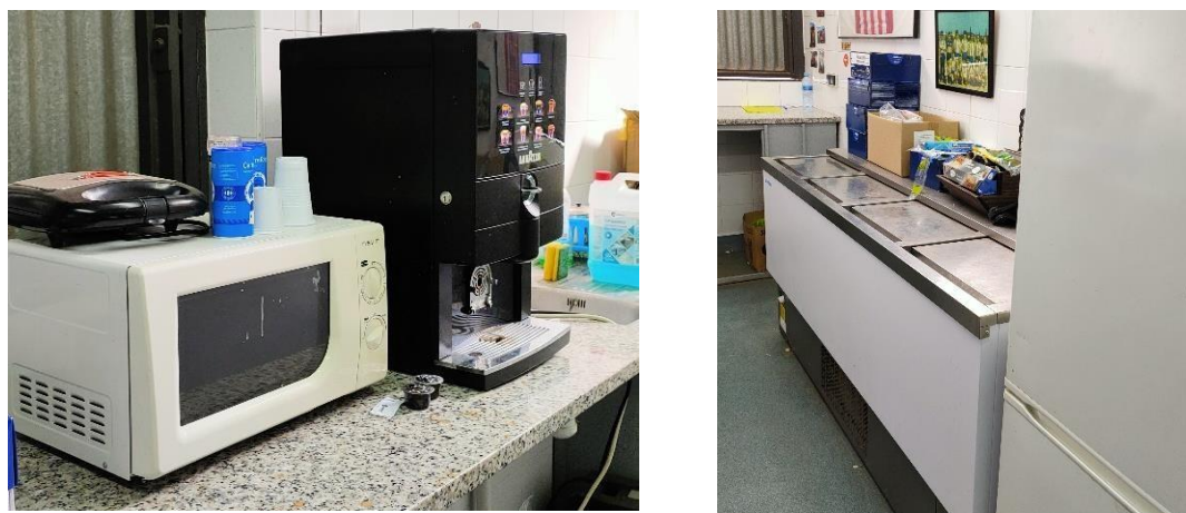
Figura 33. Equips de consum elèctric ubicats a la zona de bar de la zona esportiva . Elaboració pròpia.
