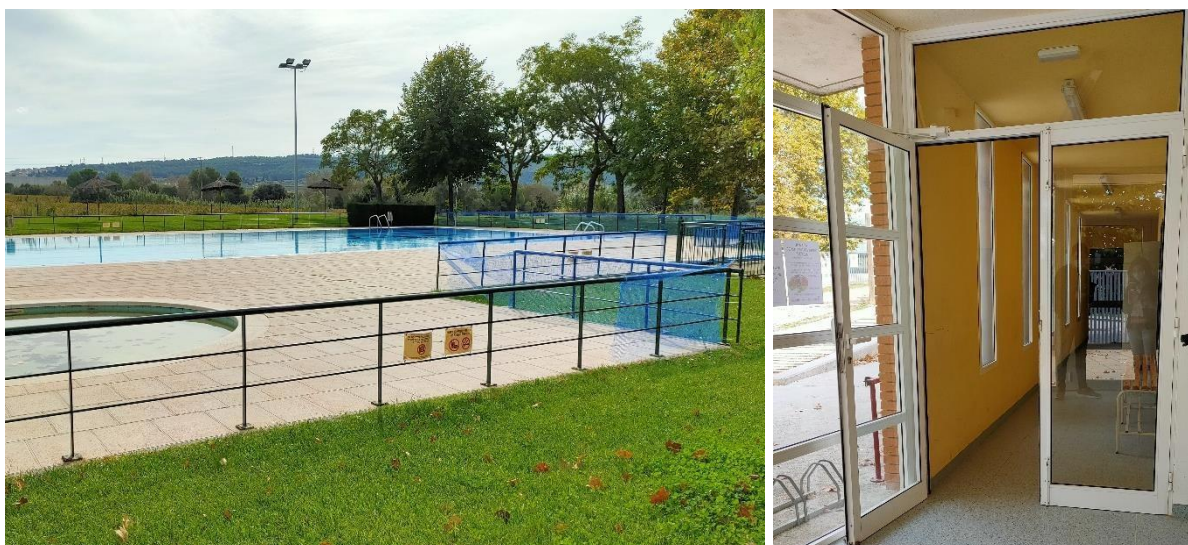
Figura 28. Instal·lacions de la piscina municipal. Piscina (esquerra), accessos als vestidors de la piscina (dreta). Elaboració pròpia.
