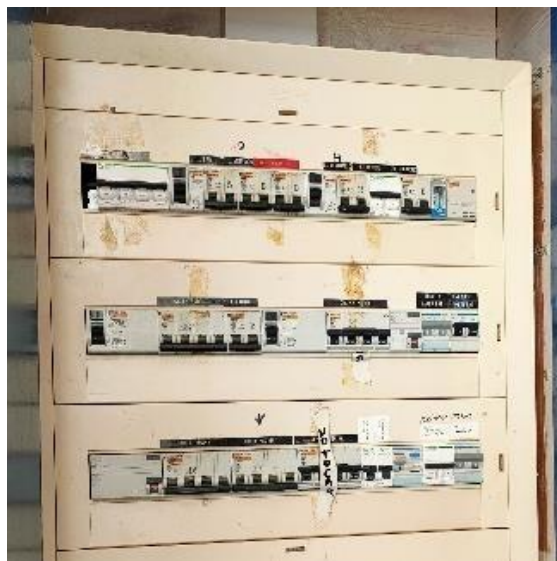
Figura 32. Quadre general de la zona de piscina a la instal·lació esportiva . Elaboració pròpia.
