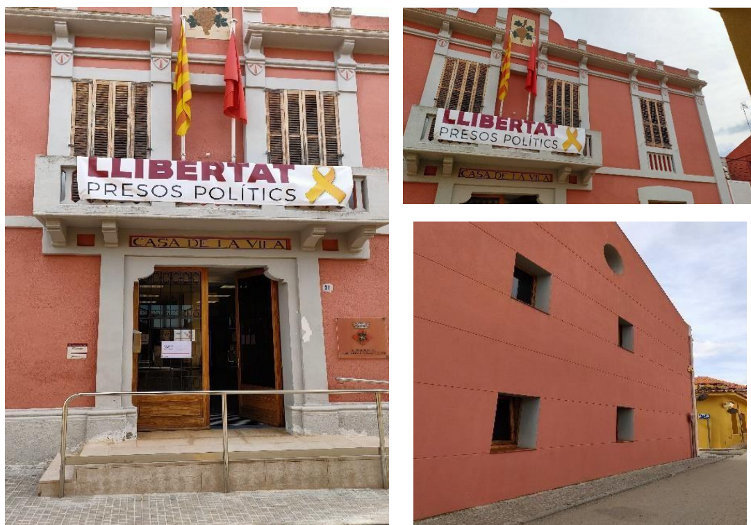
Figura 2. Fotografies de la façana de l'edifici de l'Ajuntament. Façana carrer Sant Antoni (oest) (primera i segona fotografia) i façana carrer Ponent (nord). Elaboració pròpia.
