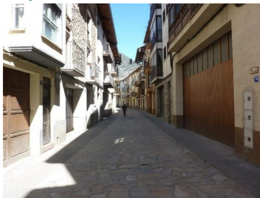
Imatge 128. Tram central carrer Nou.
