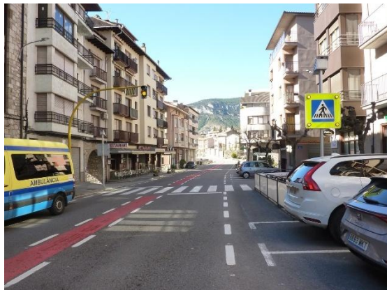
Imatge 6. Reforç de senyalització de pas de vianants a la travessera. També amb llums LED.
