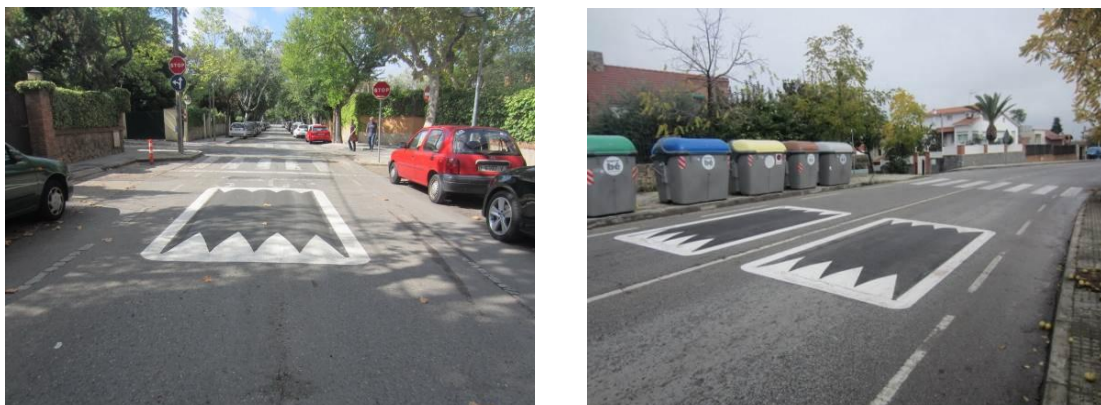
Imatge 135. Exemples de coixins berlinesos d'asfalt. Municipi de Sant Cugat del Vallès
