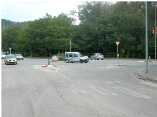
Imatge 145. Senyalització en estat deficient
