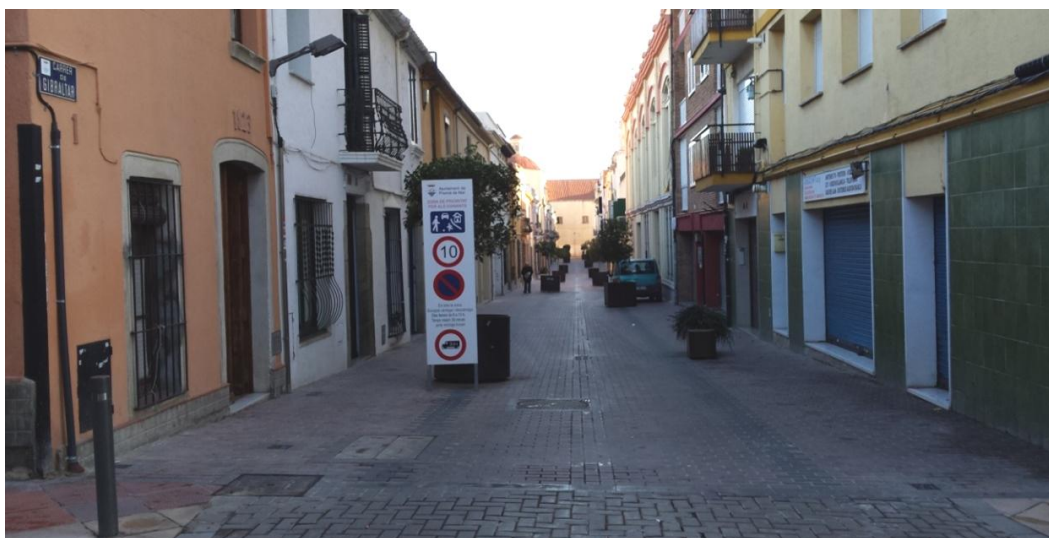
Imatge 131. Exemple de configuració de vies en plataforma única amb ús de mobiliari. Municipi de Premià de Mar
