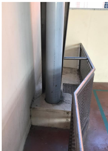
Imatges de l'actual escomesa del baixant d'aigües pluvials
