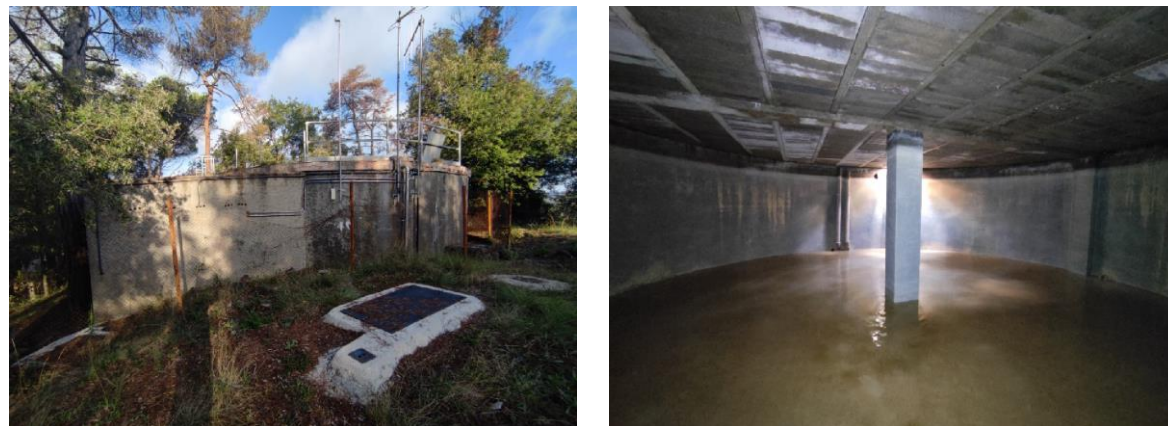
Imatge 4 : Fotografies dipòsit de Pinars, interior i exterior
