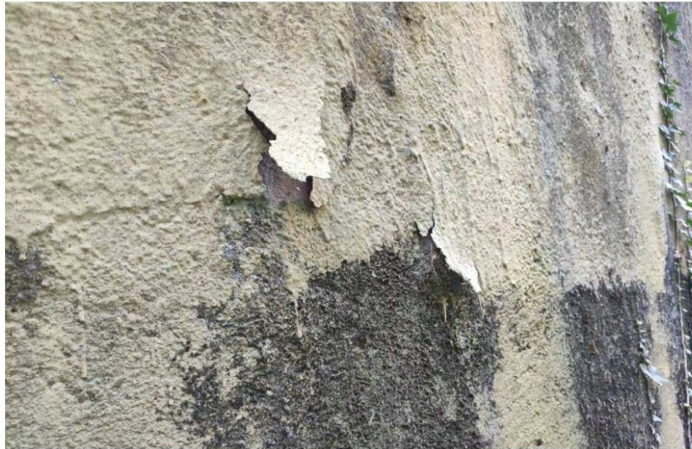
14. Revestiment impermeable després
