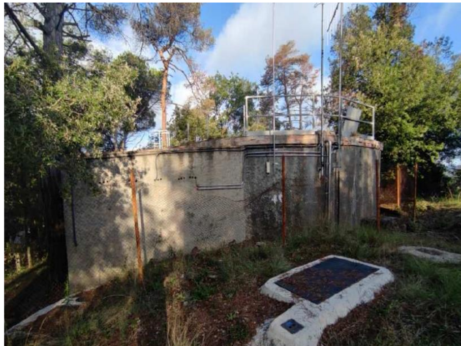
2. Vista exterior del dipòsit de Pinars.
