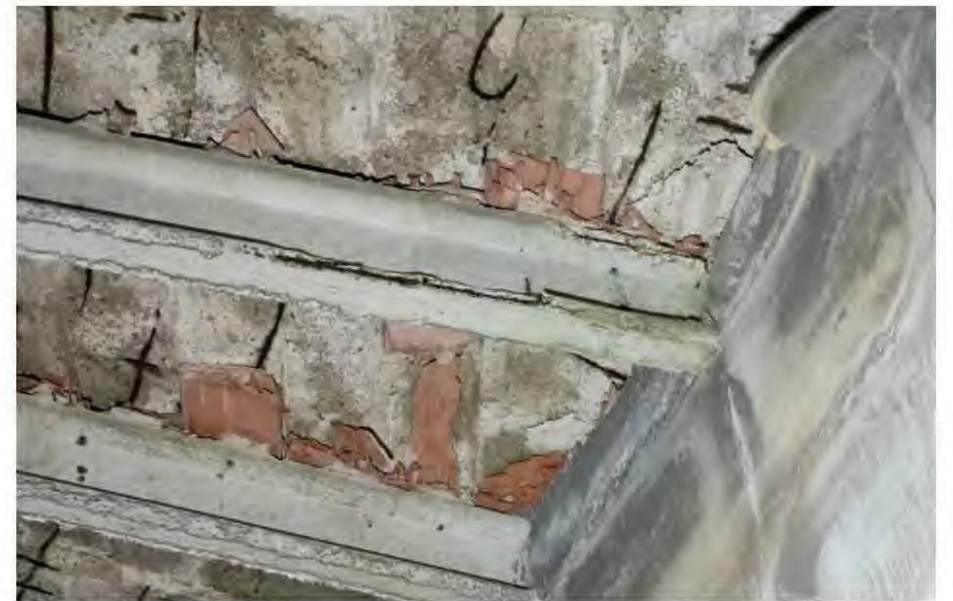
10. Escrostonamen i corrosió en bigueta 44
