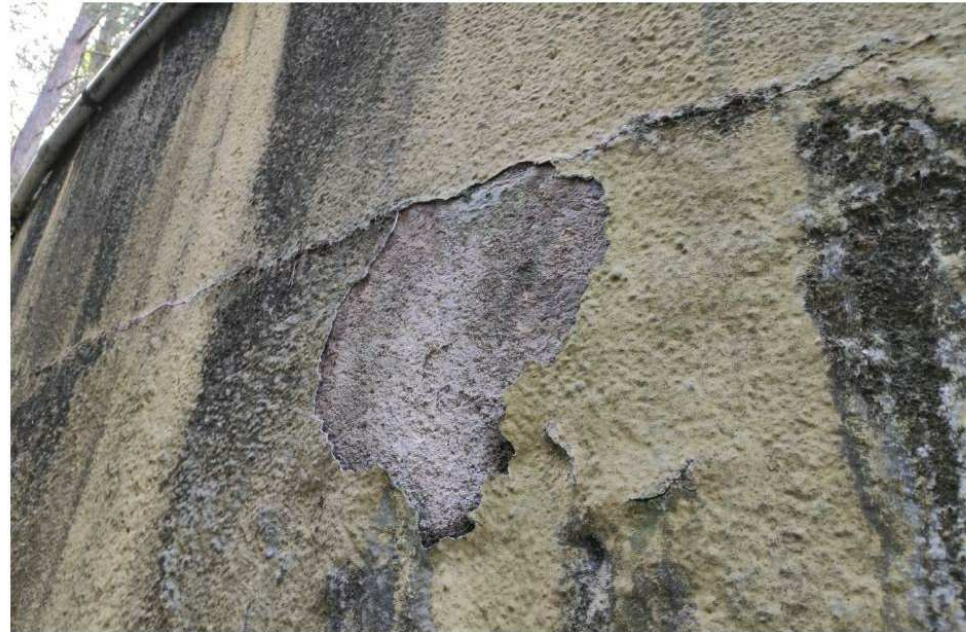
15. Revestiment impermeable després
