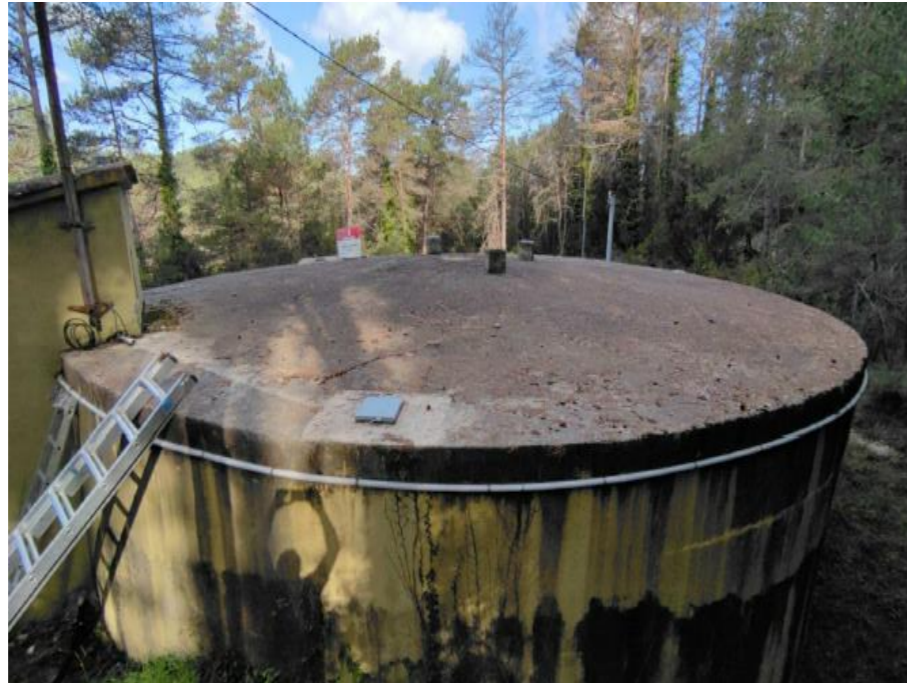
1. Vista exterior del dipòsit de Canyamera.
