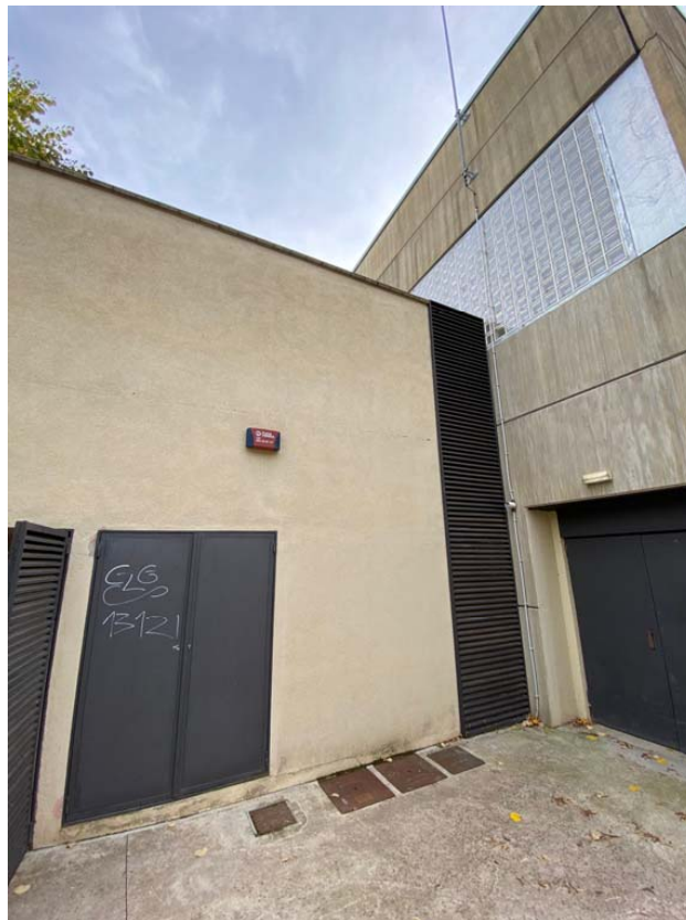
Figura 12: Zona per on circula el cablejat de CC dels inversors
