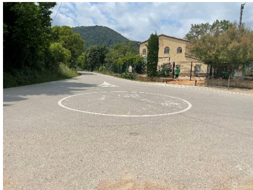
Imatge 48. Senyalització desgastada de rotonda
