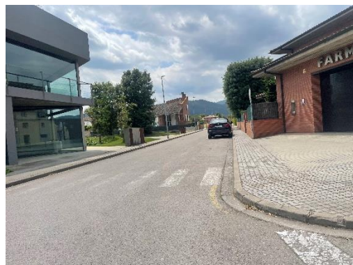
Imatge 9. Senyalització del pas de vianants desgastada.
