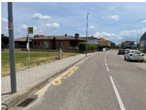
Imatge 8. Senyalització horitzontal per la parada de l'autobús al entrar a la trama urbana.
