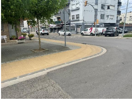
Imatge 18. Ampliació de vorera amb orella en una via secundària.
