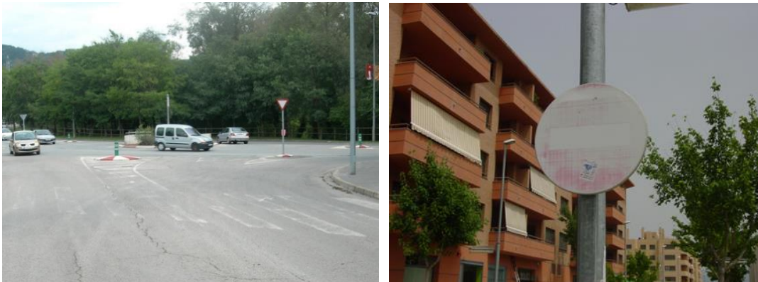
Imatge 63. Senyalització en estat deficient
