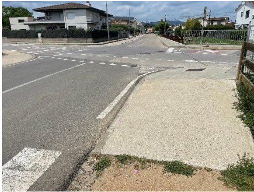
Imatge 34. Pendent per fer la connexió del camí de terra amb la vorera del carrer de l'Estació
