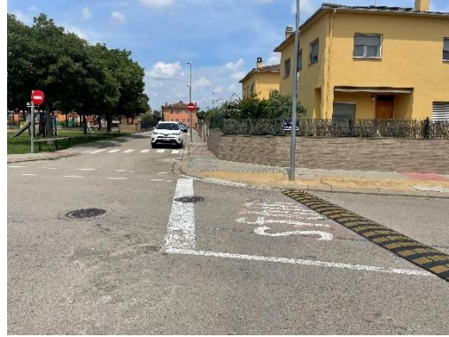
Imatge 39. Línia de detenció amb estop després del reductor vertical
