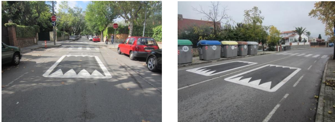
Imatge 58. Exemples de coixins berlinesos d'asfalt. Municipi de Sant Cugat del Vallès
