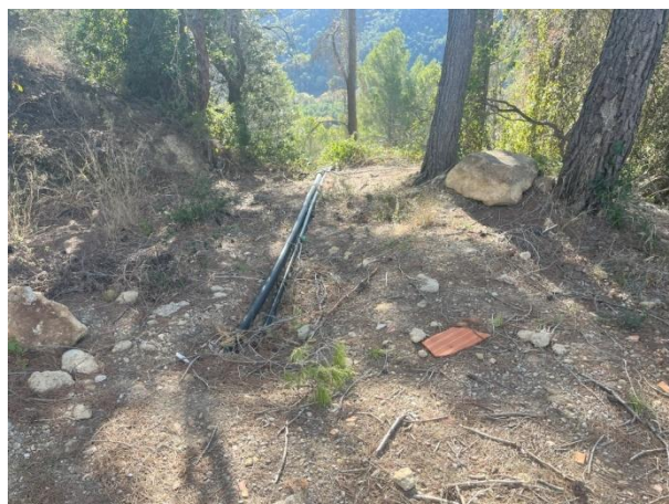
Fotografia 14. Vista conduccions provisionals
