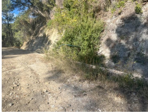
Fotografia 12. Vista conduccions provisionals
