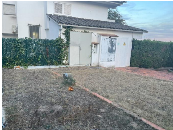
Fotografia 4. Vista general del dipòsit soterrat i instal·lació elèctrica
