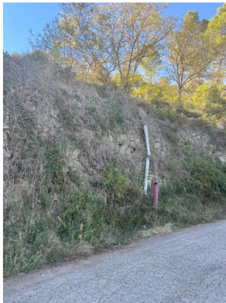
Fotografia 11. Vista conduccions provisionals
