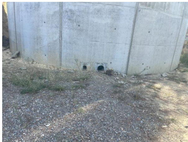
Fotografia 8. Passamurs previstos conduccions dipòsit
