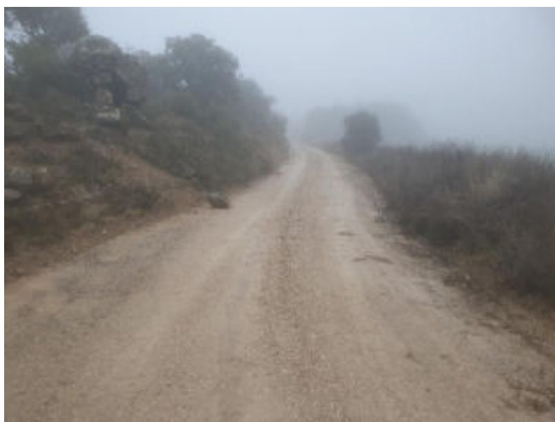
Paviment amb MBC (Tram 3-4)
