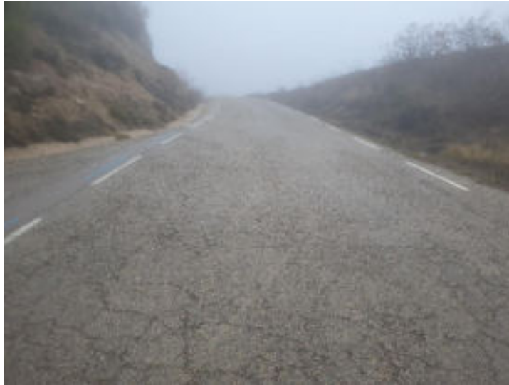
Paviment amb MBC (Tram 3-4)
