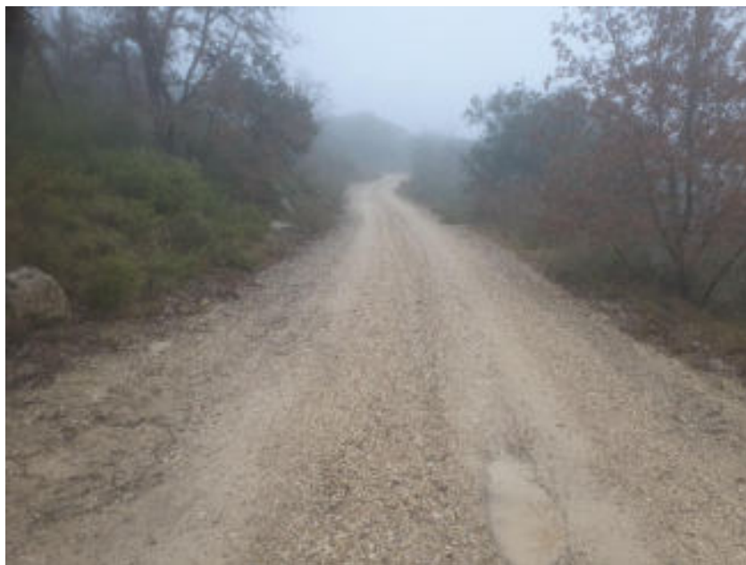
Paviment amb MBC (Tram 1-2)
