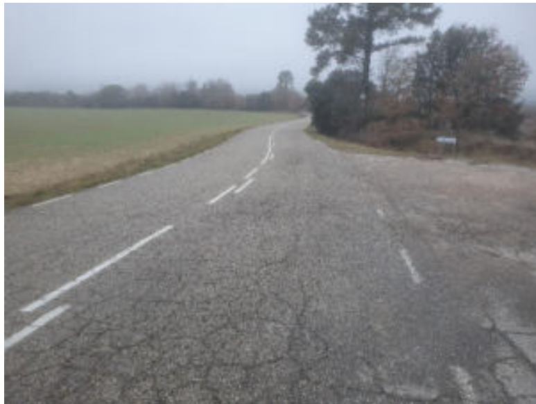
Paviment amb MBC (Tram 9-10)
