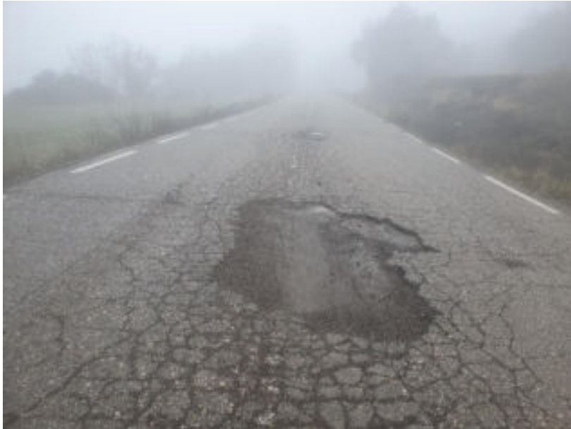
Paviment amb MBC (Tram 1-2)
