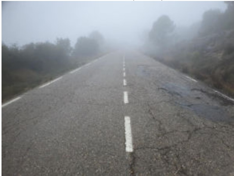
Paviment amb MBC (Tram 3-4)
