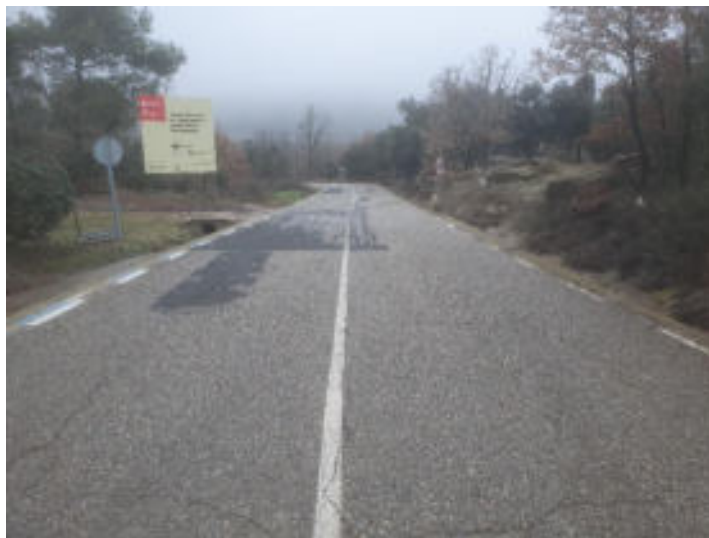
Paviment amb MBC (Tram 3-4)
