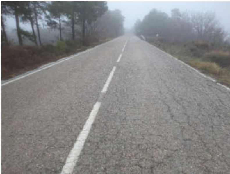
Paviment amb MBC (Tram 1-2)
