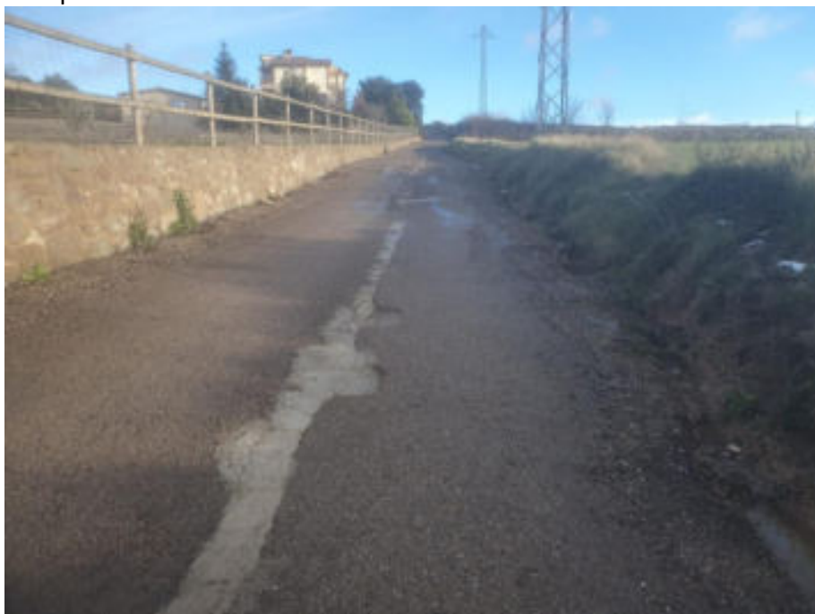
Paviment amb MBC
