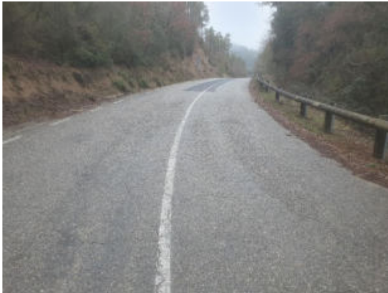
Paviment amb MBC (Tram 1-2)
