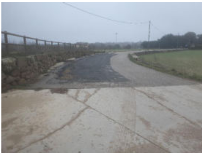
Paviment amb MBC (Tram 5-6)
