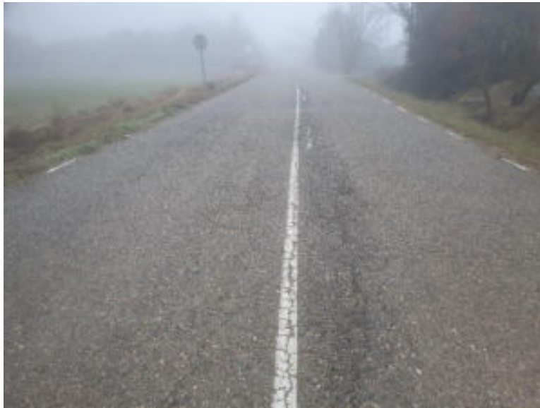
Paviment amb MBC (Tram 11-12)
