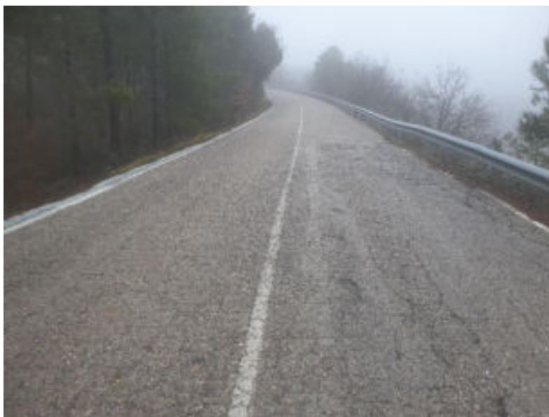
Paviment amb MBC (Tram 3-4)
