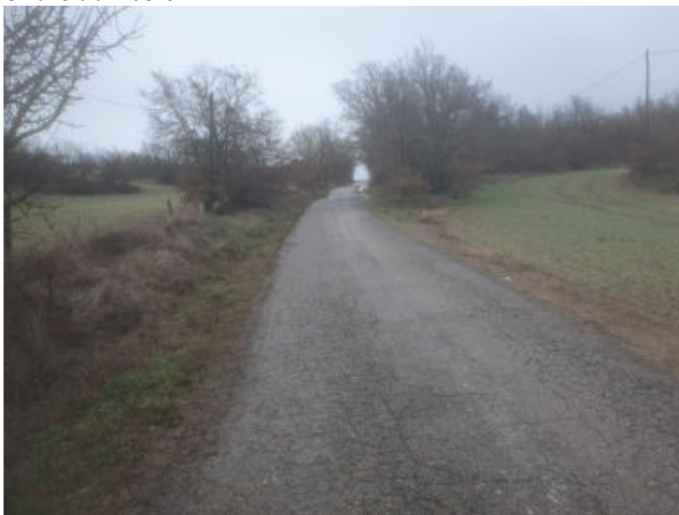
asfalt MBC - tram 1-2
