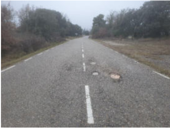
Paviment amb MBC (Tram 7-8)
