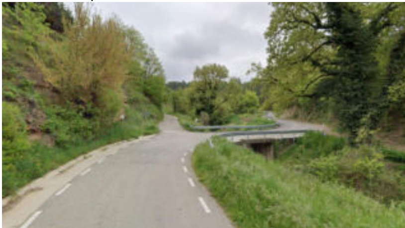
Paviment amb MBC – Flonjall 7 i Asfaltat 1-2
