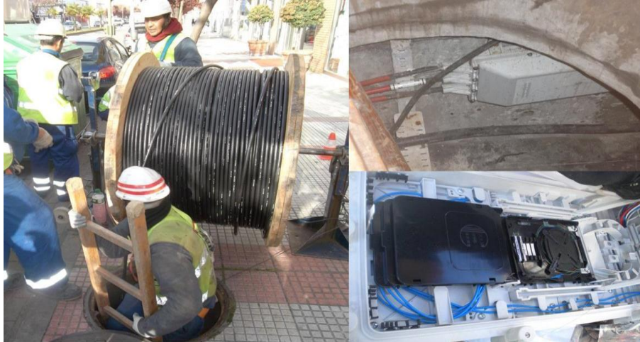
Il·lustració 12. Estesa i empiulament de cables en canalització.
