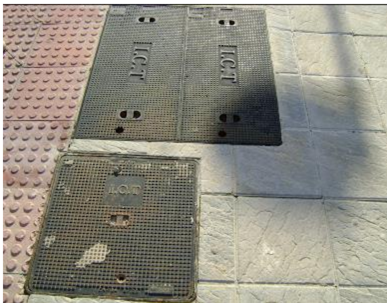
Il·lustració 13. Arqueta d'entrada a edifici amb desplegament interior.
