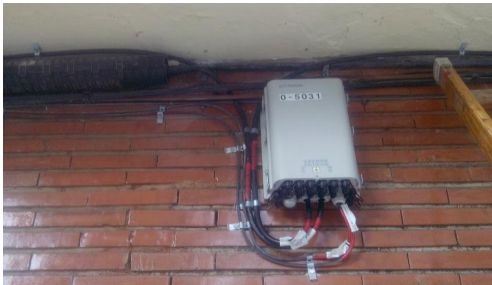
Il·lustració 18. Detall Caixa terminal òptica (CTO) exterior.
