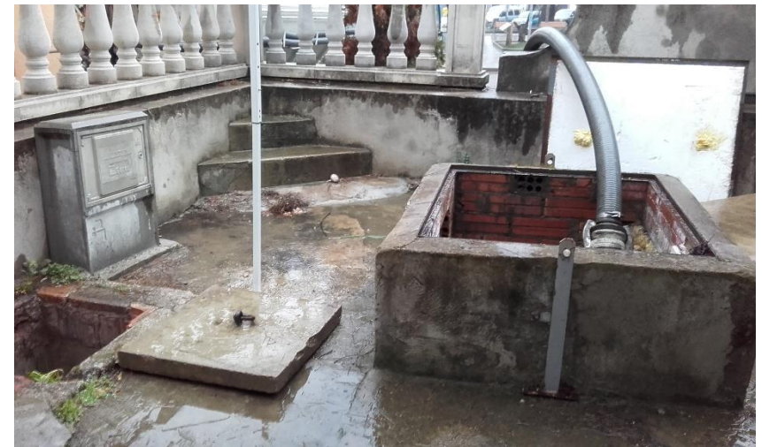
Foto 3. Obertures a la captació durant la neteja
