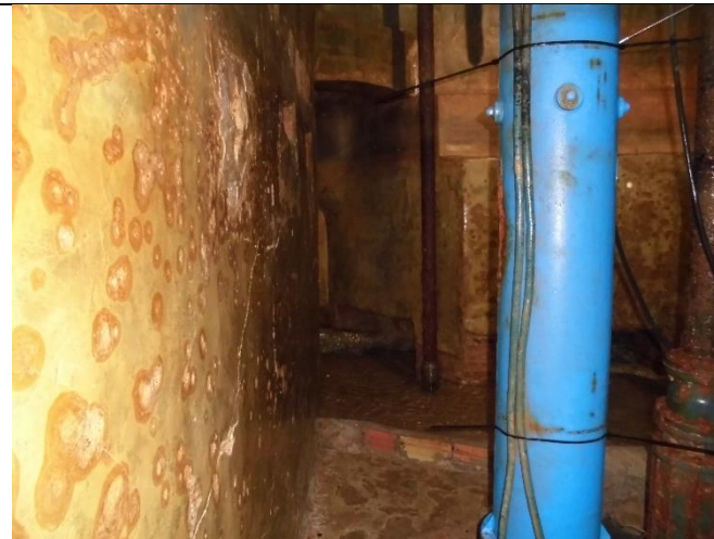
Foto 5. Interior de la captació.
