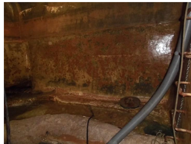
Foto 7. Interior de la captació.
