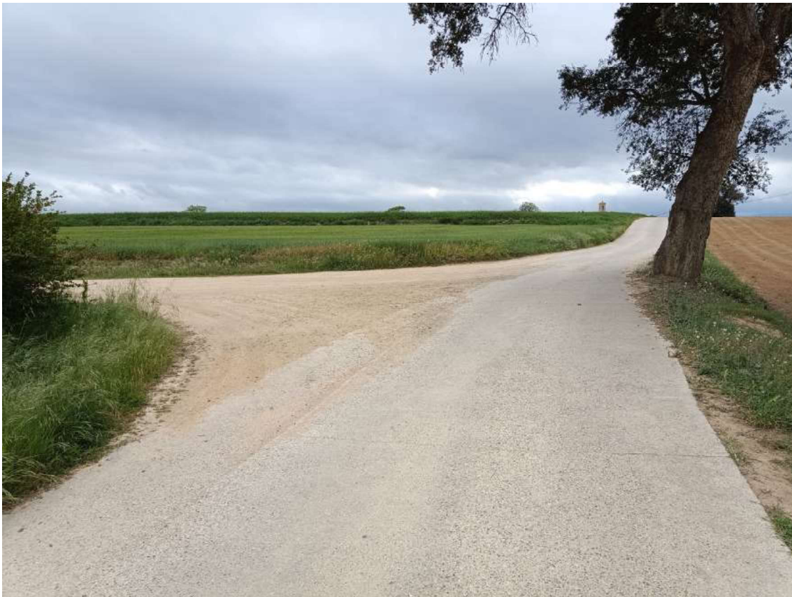
Figura 14: Vista des del punt B. El nou camí serà visible.
