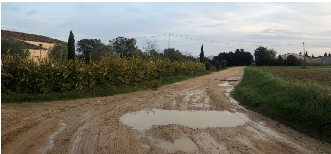
Figura 1: Vista del camí existent al seu pas per l'habitatge.
