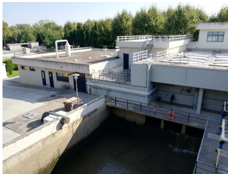
Bassa de recuperació d'aigua
