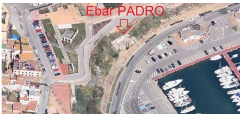
Figura 1. Situació i emplaçament de l'EBAR El Pedró (Carrer Voramar, s/n de Palamós)
