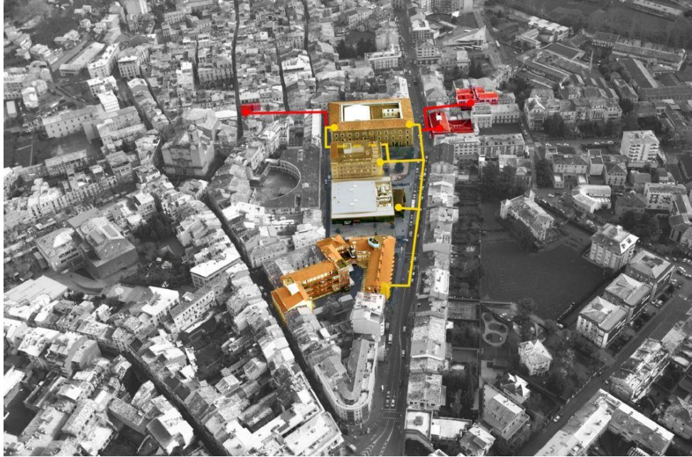
Edificios públicos de la primera fase del distrito energético de Olot.
