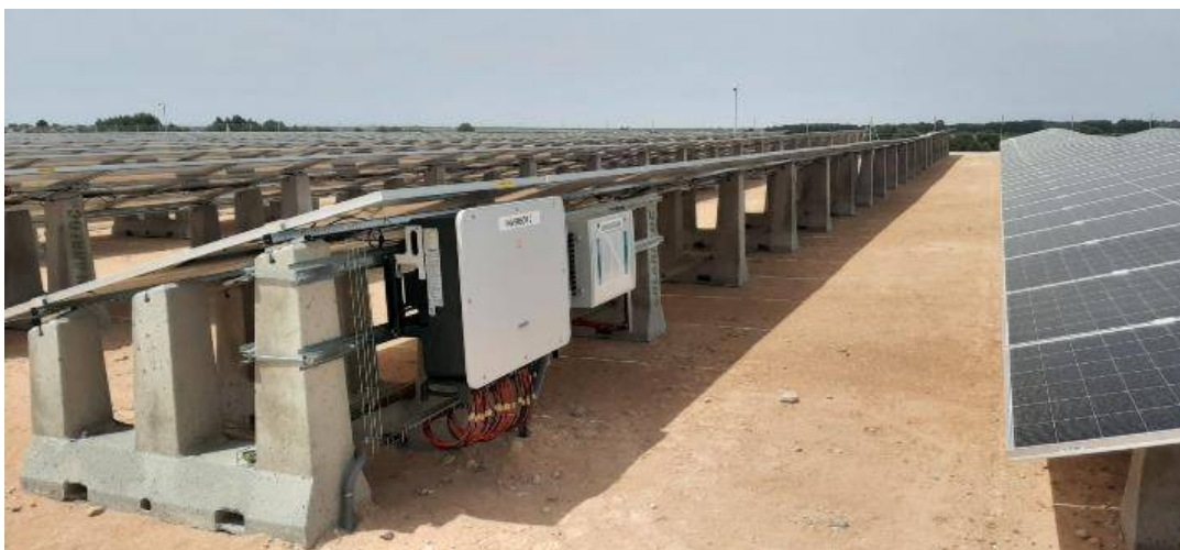
Exemple estructura autoportant amb mòduls en vertical sobre blocs de formigó i perfils metàl·lics (font: SOLARBLOC).
