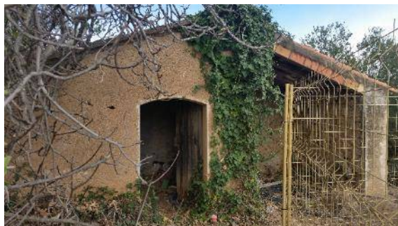
12. Vista frontal d'edificació existent a demolir
