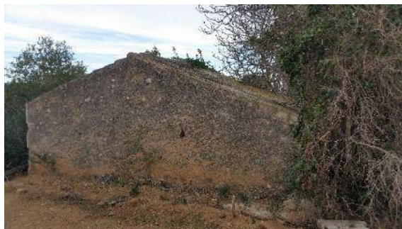
10. Vista posterior d'edificació existent a demolir
