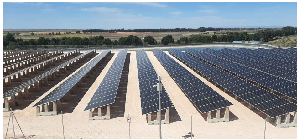
EXEMPLE IMPLANTACIÓ AMB BLOCS DE FORMIGÓ I MÒDULS EN VERTICAL (font: SOLARBLOC)
