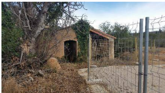
11. Vista frontal d'edificació existent a demolir
