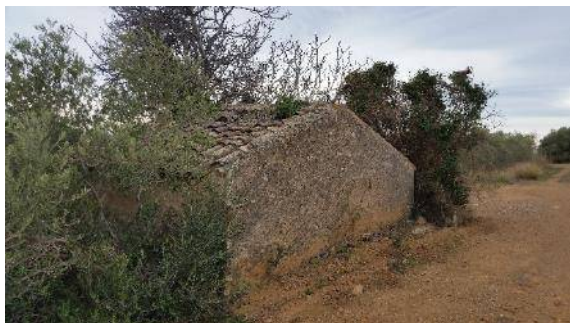
9. Vista posterior d'edificació existent a demolir
