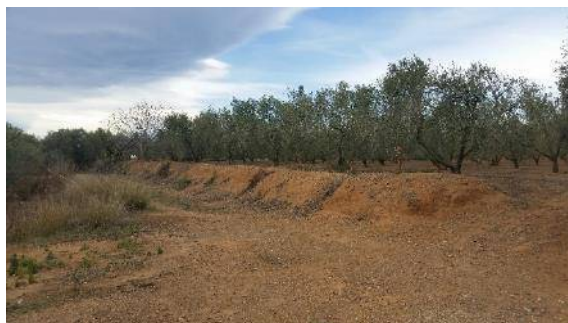
6. Vista talús existent
