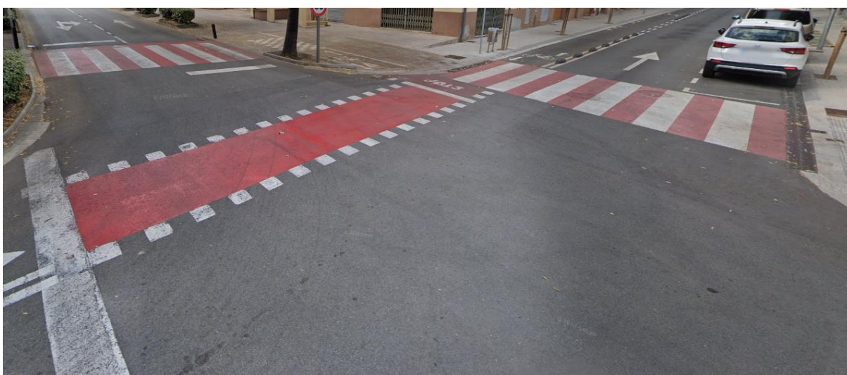
Ús actual de passos elevats a la intersecció de l'Avda. Puig i Ferrater amb el carrer Joan Domingo
