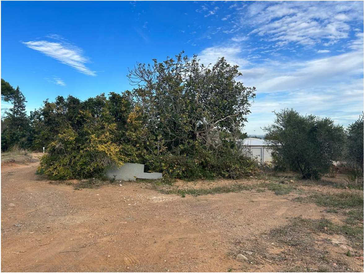
Vista del dipòsit nou, des de la part oest de la parcel·la núm.15
