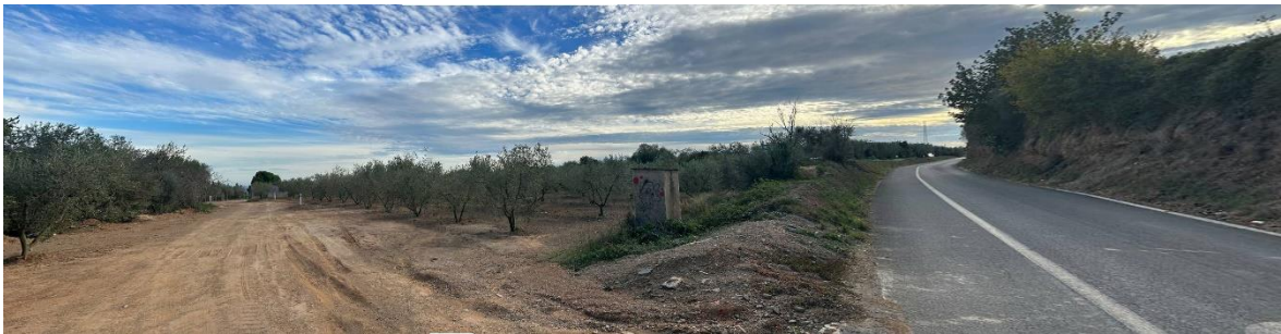
Vista del subàmbit 1 de la Modificació puntual des de la carretera T-3231
