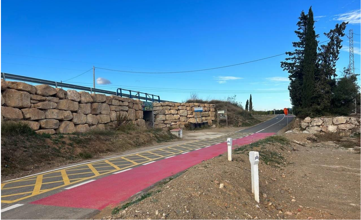
Vista de la carretera T-3231, de la Selva a Almofter, antic tram a baix, per on passa la canonada del CAT.
