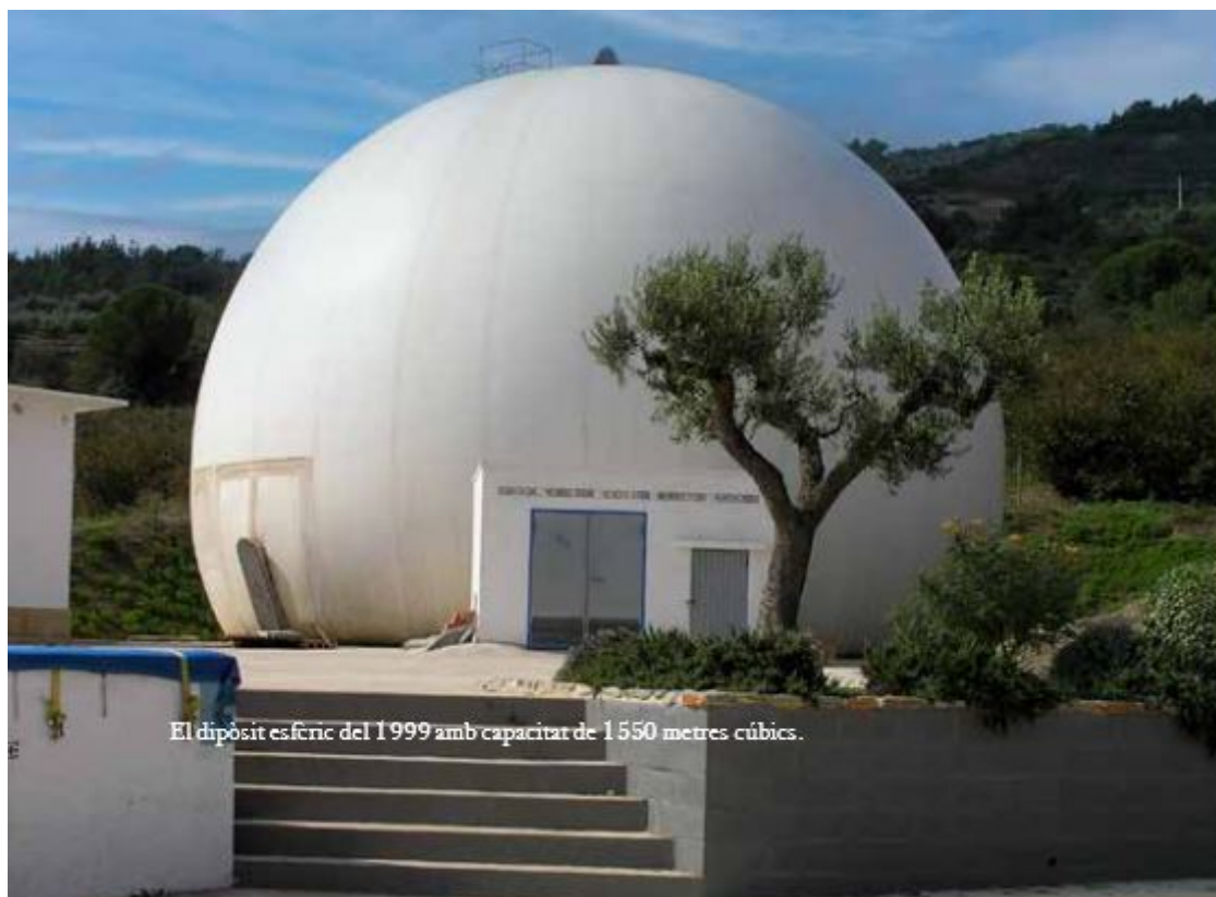
Vista del dipòsit esfèric de 1.550 m 3 i de les instal·lacions annexes. Font: publicació de l'Ajuntament.
