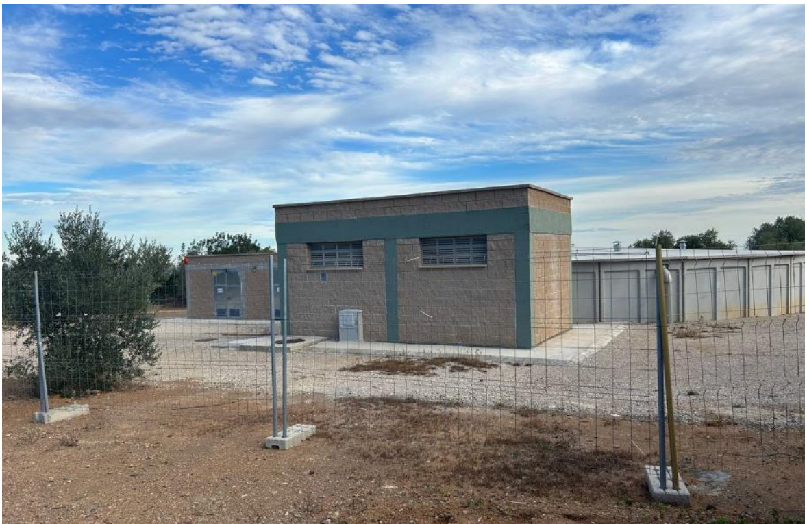
Vista del dipòsit nou de 1.000 m3 i de les instal·lacions annexes
