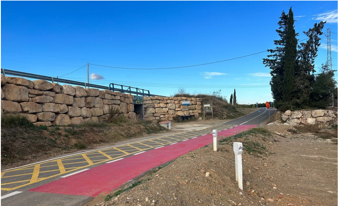
Vista de la carretera T-3231, de la Selva a Almofter, antic tram a baix, per on passa la canonada del CAT.
