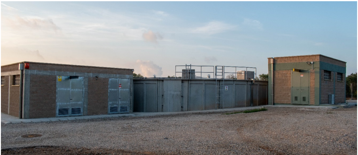
Vista del dipòsit nou de 1.000 m3 i de les instal·lacions annexes
