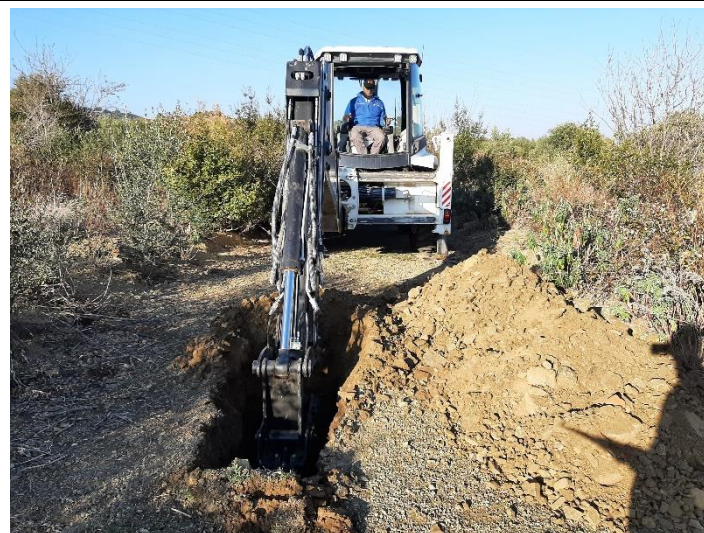
Foto 36. Ubicación calicata C-13.
