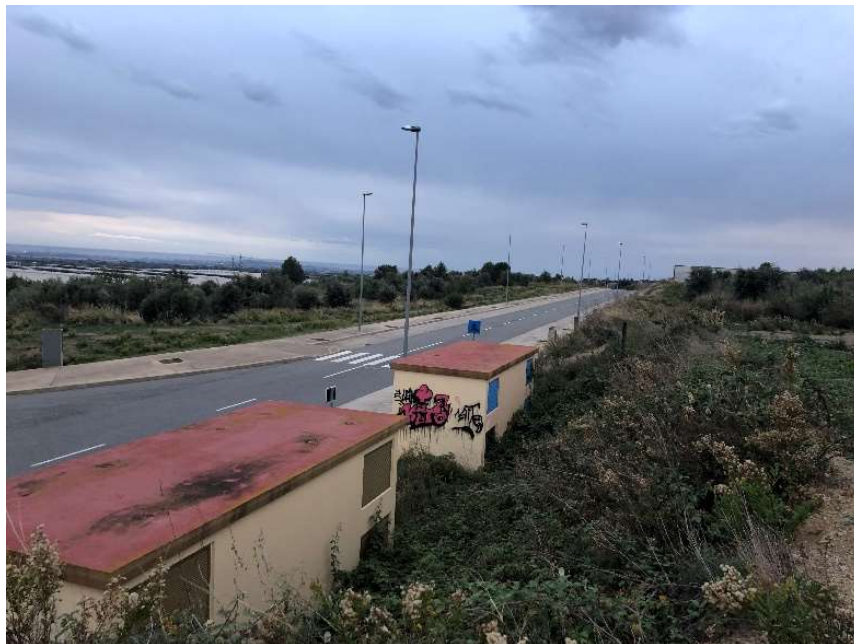
Imagen 40 Edificio prefabricado de hormigón vacío en la actualidad para alojar un posible centro de transformación
