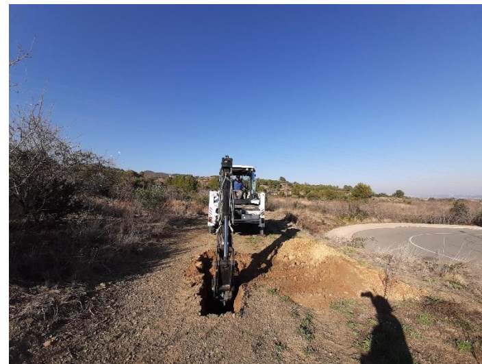
Foto 28. Ubicación calicata C-10,
