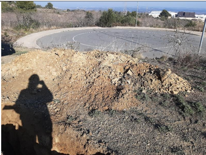
Foto 29. Material extraído de la calicata C-10.
