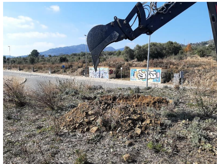
Foto 16. Ubicación de la calicata C-6
