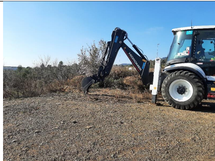
Foto 10. Ubicación calicata C-4.
