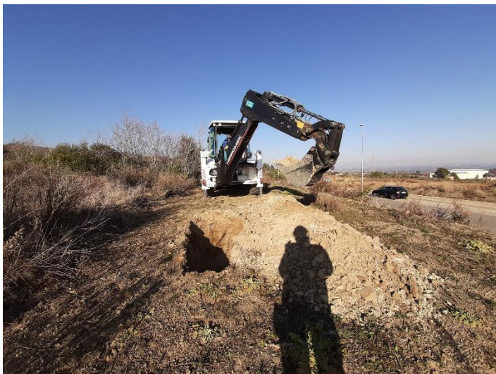
Foto 31. Ubicación calicata C-11.
