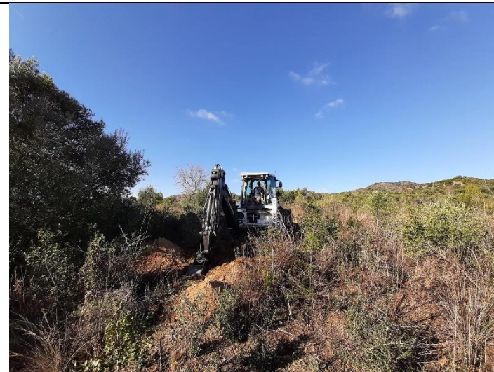
Foto 50. Ubicación calicata C-17.
