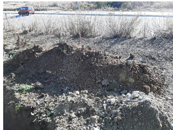
Foto 44. Material extraído de la calicata C-15.
