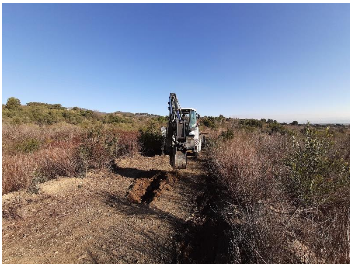
Foto 47. Ubicación de la calicata C-16.
