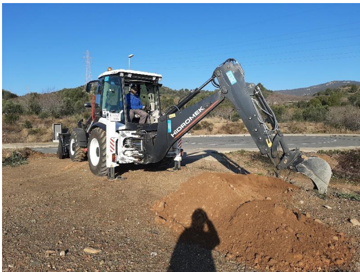
Foto 7. Ubicación calicata C-3.
