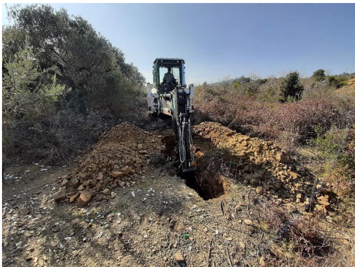
Foto 23. Material extraído de calicata C-8.
