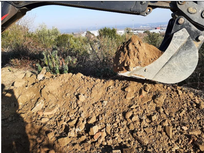
Foto 37. Material extraído de la calicata C-13.
