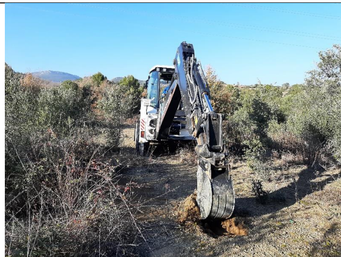
Foto 34. Ubicación calicata C-12.
