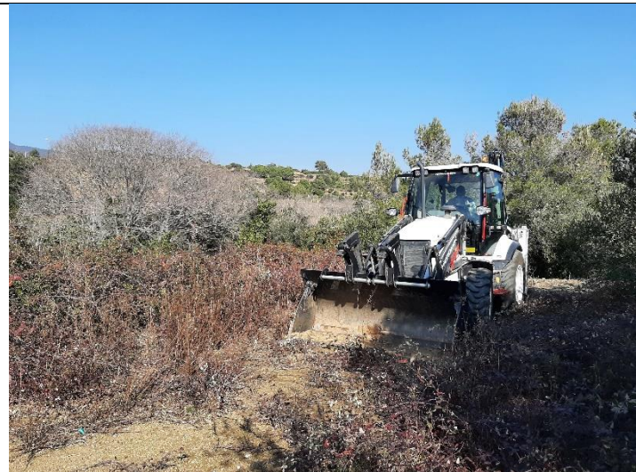
Foto 22. Ubicación calicata C-8.
