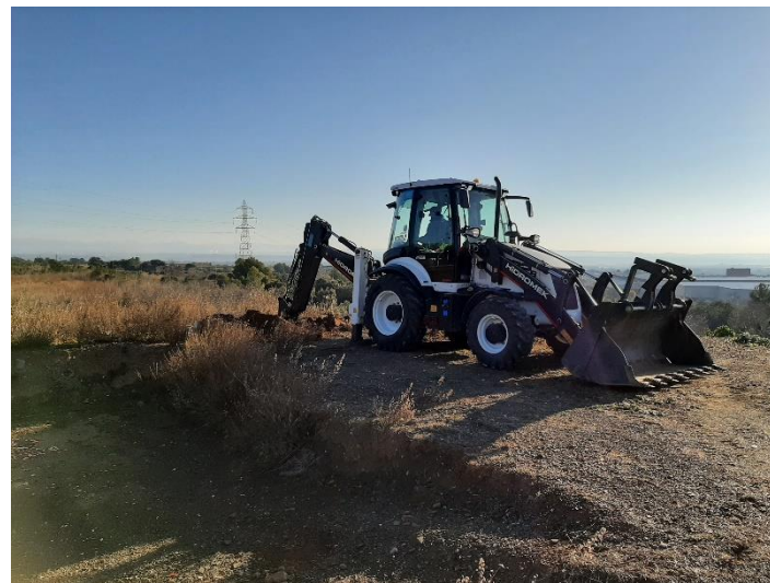
Foto 4. Ubicación calicata C-2.
