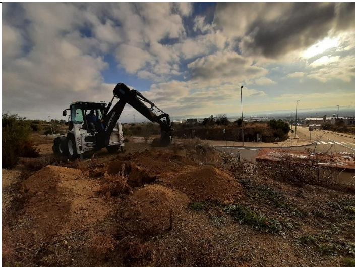
Foto 41. Material extraído de la calicata C-14.
