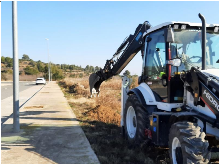
Foto 13. Ubicación calicata C-5.
