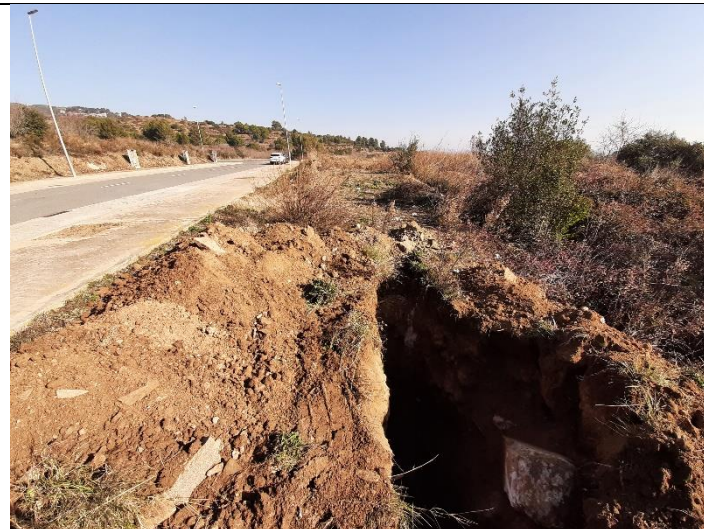
Foto 14. Material extraído de la calicata C-5.
