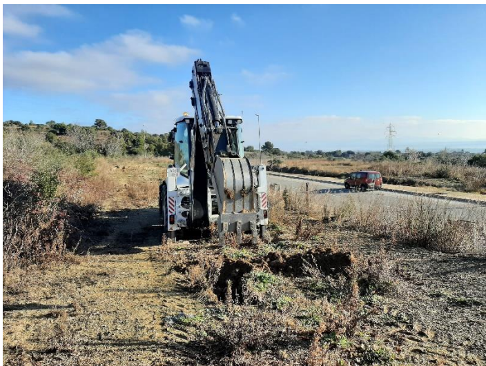
Foto 43. Ubicación calicata C-15.
