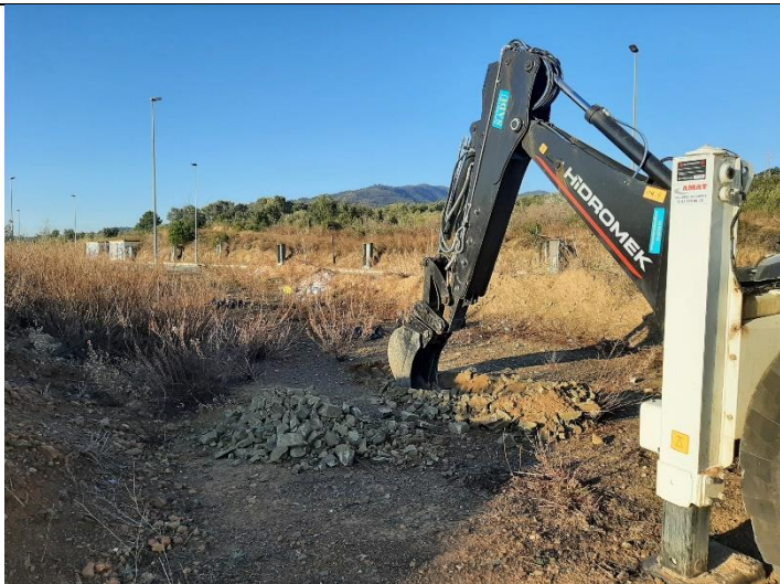
Foto 1. Ubicación calicata C-1
