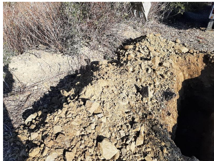
Foto 48. Material extraído de la calicata C-16.
