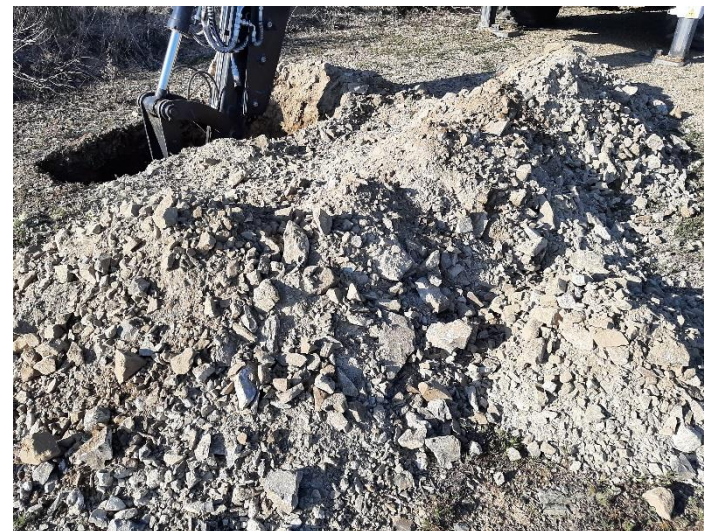
Foto 32. Material extraído de la calicata C-11.
