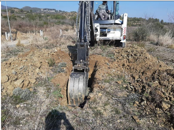
Foto 17. Material extraído de la calicata C-6.
