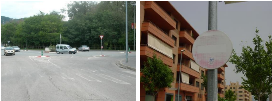
Imatge 51. Senyalització en estat deficient
