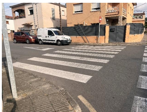
Imatge 13. Pas de vianants no accessible.
