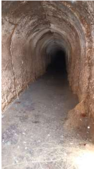
Imatge 4 – Captació mina
