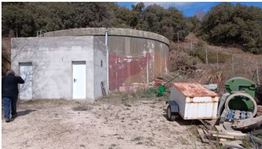
Imatge 9 – Dipòsit de 400 m3
