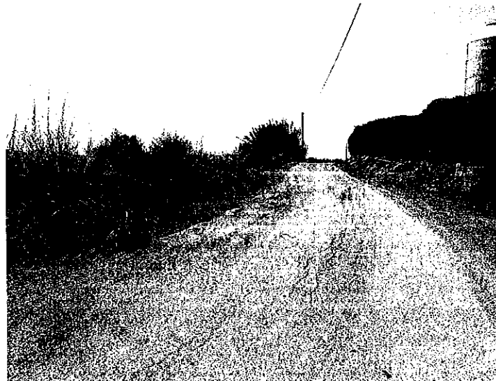
Llocs on s'han de realitzar cunetes americanes on les aigües de pluja i finques veïnes malmeten el camí.
