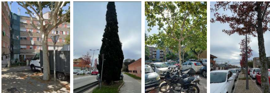
Fotografies 9,10 11 i 12.- D'esquerra a dreta, exemples de conflictes de l'arbrat viari: (1) Paviments aixecats; (2) conflicte amb senyal; (3) conflicte amb trànsit; (4) i arbres en vorera estreta (<2,5m).
