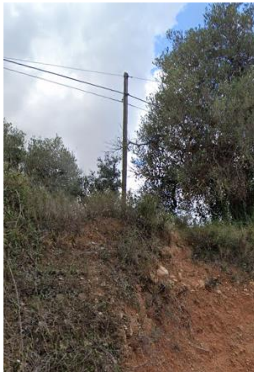
A.3.10. Suport 10: P-10, coordenades X: 339.727 - Y: 4.560.904. Substituir suport de fusta 8 E a fusta 8 D.
