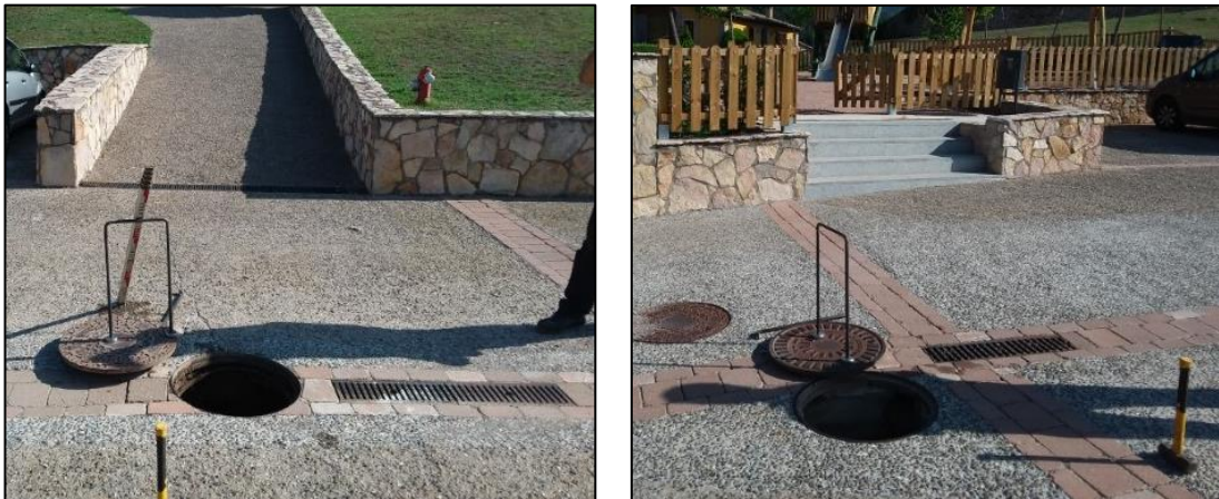
Figura 17: Exemples dels elements d'intercepció d'escorrentia superficial
