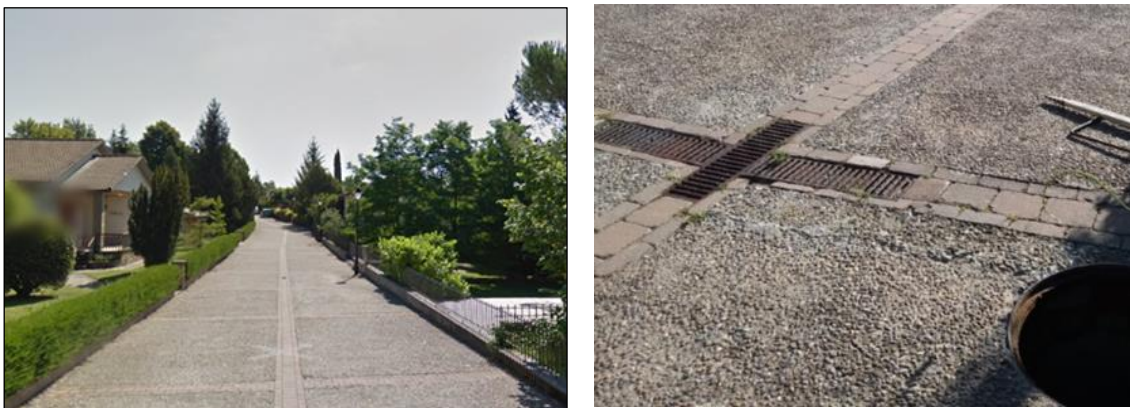
Figura 3: Carrer De l'Església (Sora) i sistemes actuals d'intercepció d'aigües pluvials
