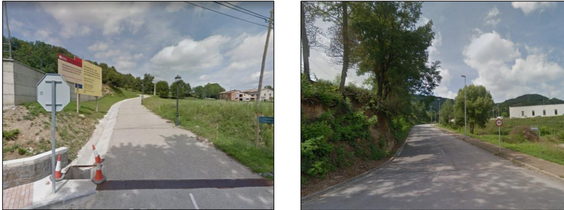
Figura 7: Canal superficial nucli urbà de Cussons i torrentera sota paviment al Polígon industrial la Teuleria
