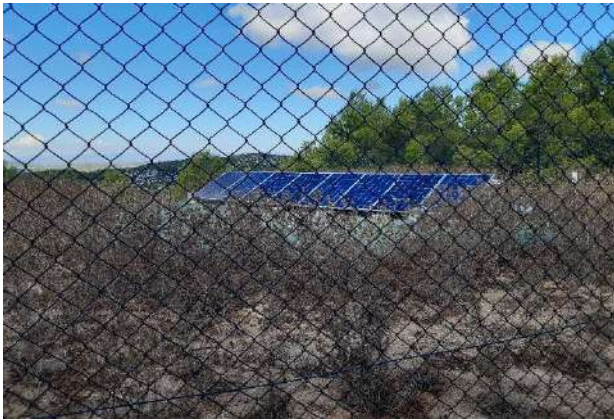
Dipòsit existent amb plaques solars
