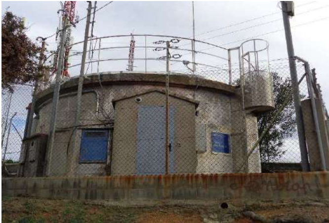
Captació: dipòsit aigua potable existent
