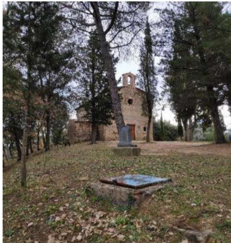
Figura 13 - Exterior Dipòsit Ermita Sant Roc.
