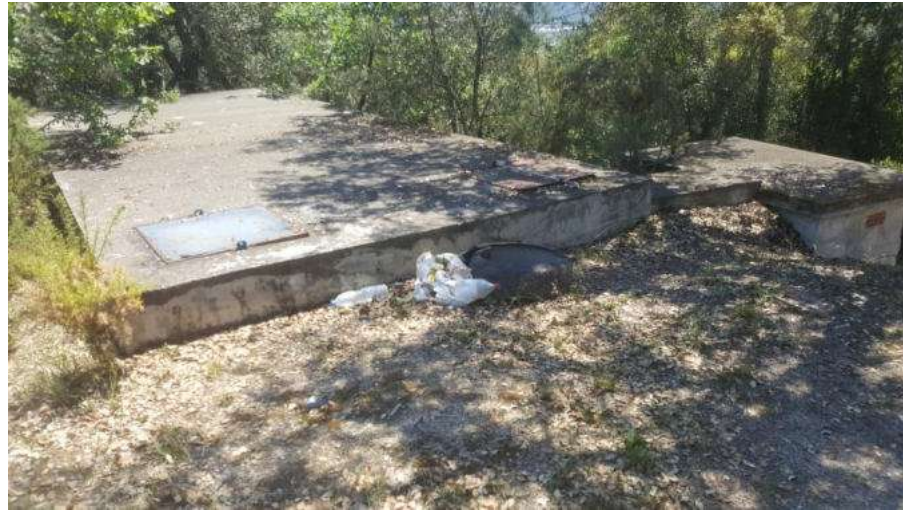
Figura 28 - Exterior Dipòsit Can Piu.
