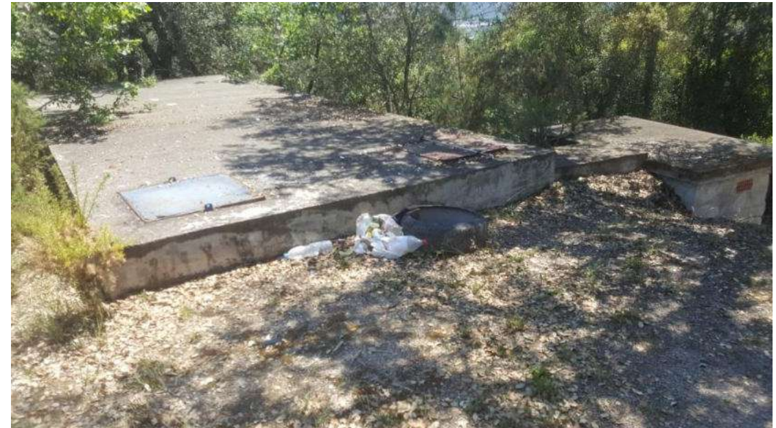
Figura 11. Exterior Dipòsit Can Piu.
