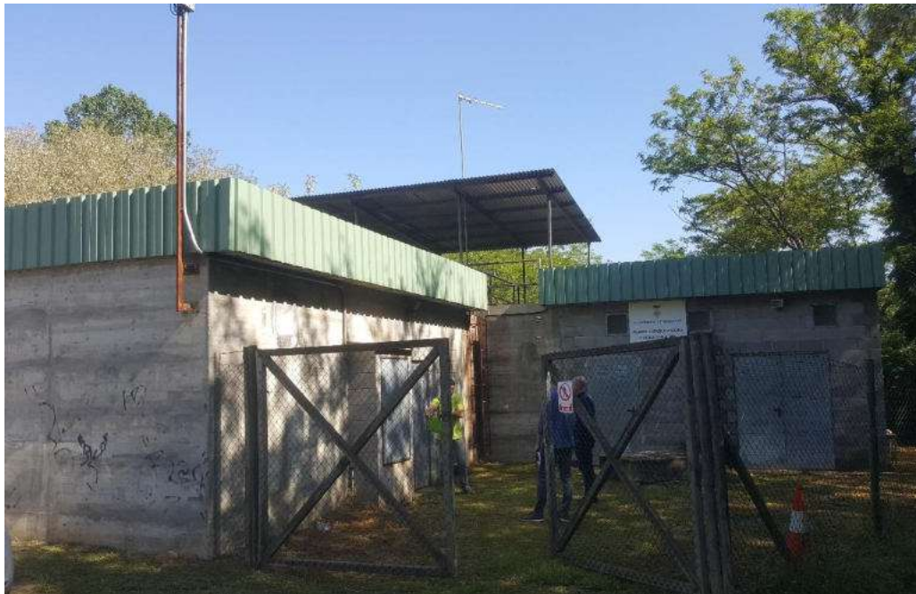
Figura 6 - Exterior Dipòsit ETAP.
