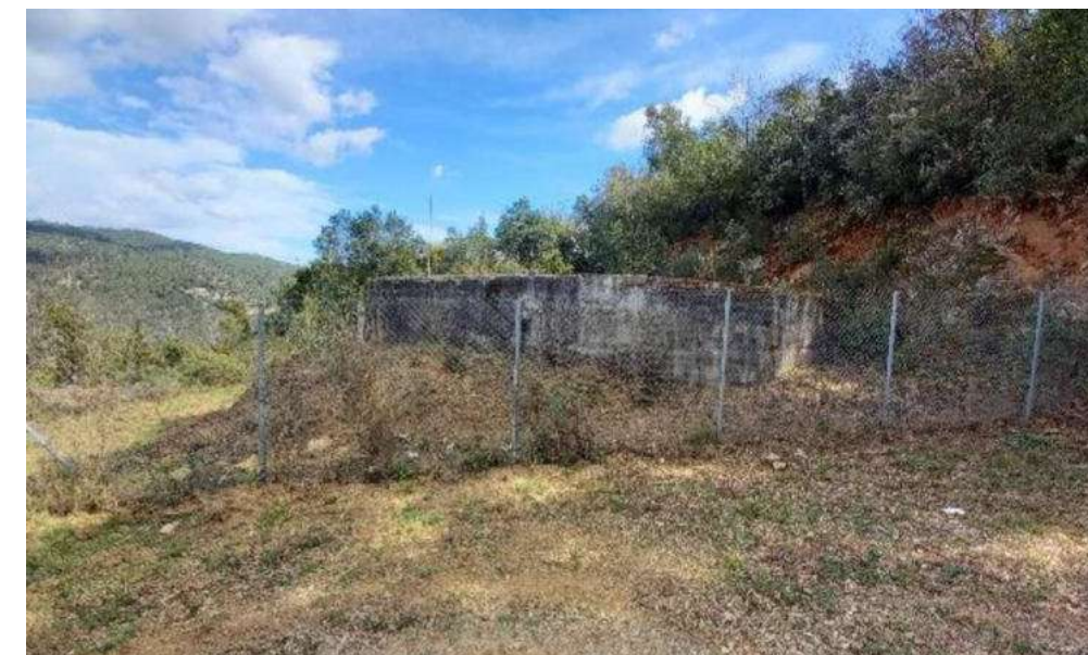
Figura 15 - Exterior Dipòsit Riu Clar.
