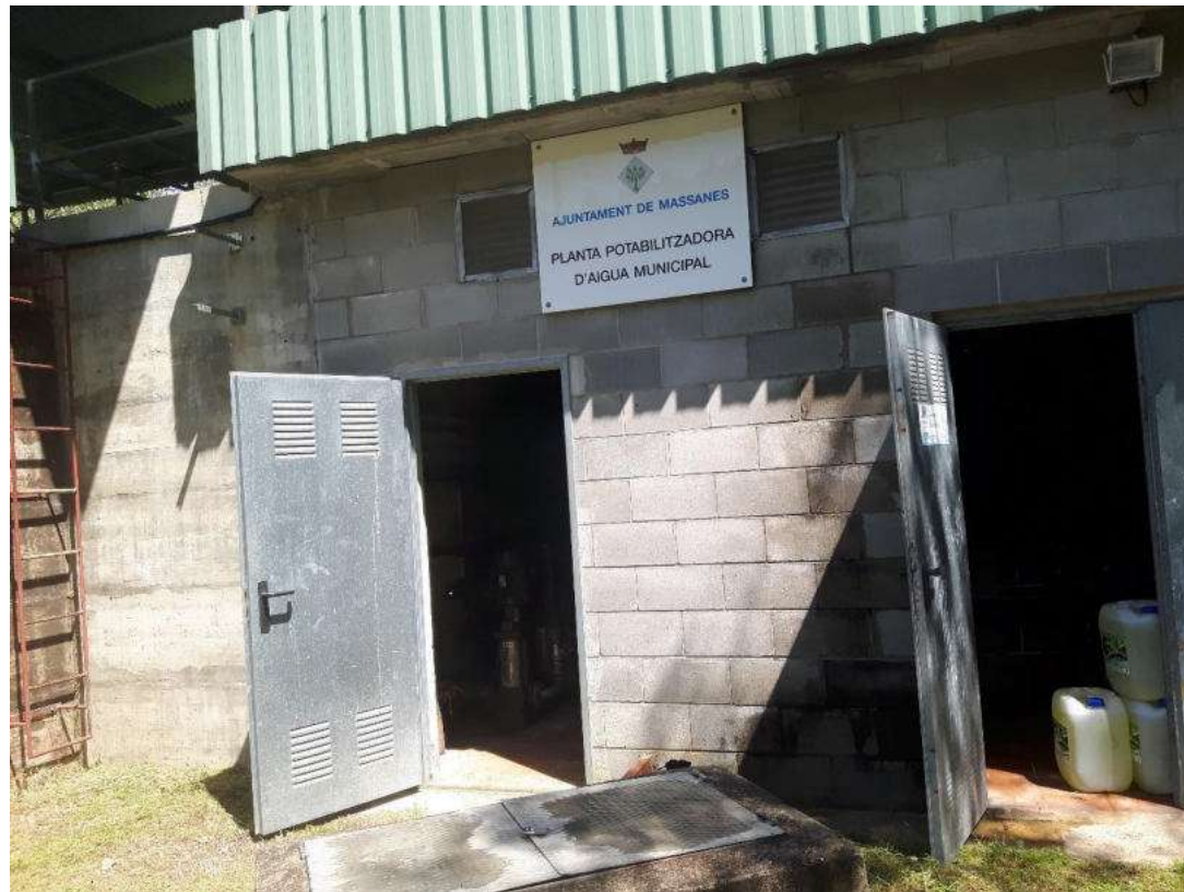
Figura 9 - Exterior de l'ETAP Massanes.
