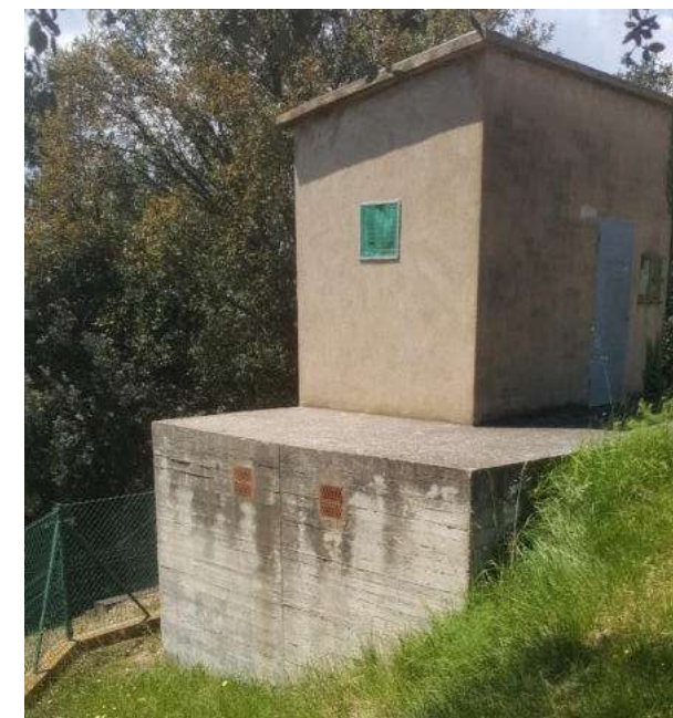
Figura 8 - Exterior Dipòsit Ca l'Espardanyer.
