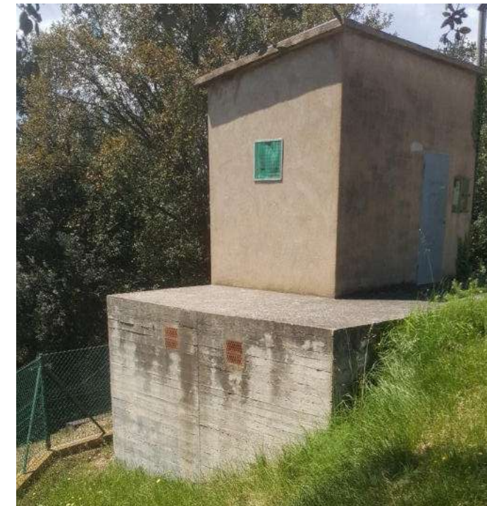
Figura 27 - Exterior Dipòsit Ca l'Espardanyer.
