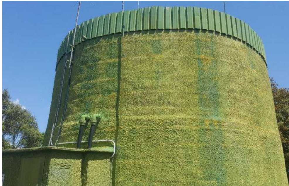
Figura 5 - Exterior Dipòsit de Can Regàs.
