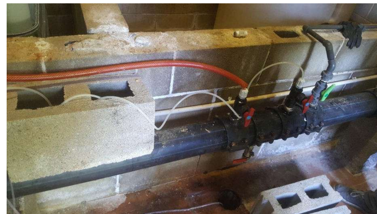
Figura 18 - Injecció de reactius a l'ETAP.
