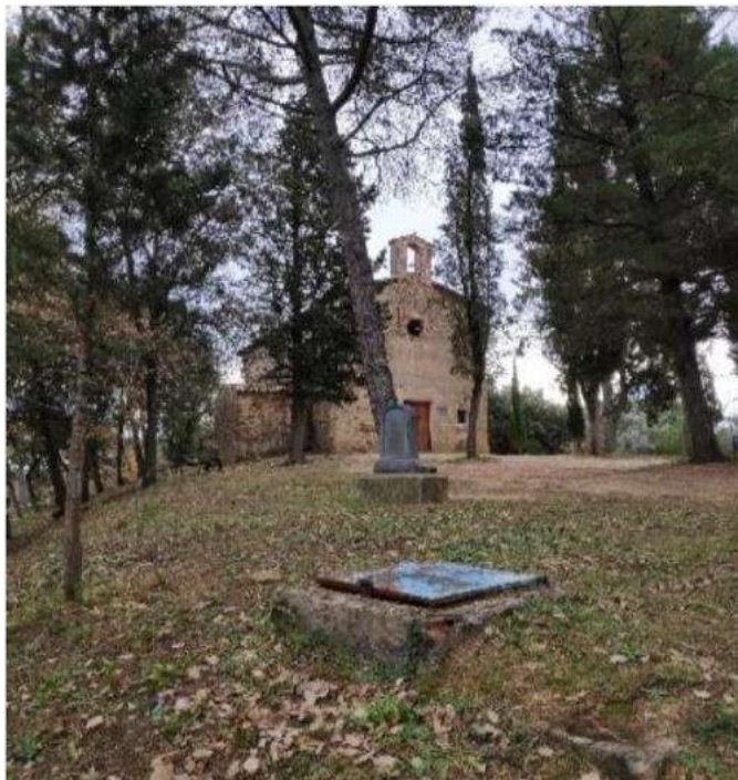
Figura 29 - Exterior Dipòsit Ermita Sant Roc.
