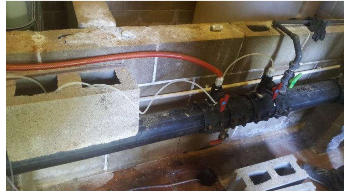
Figura 10 - Injecció de reactius a l'ETAP.
