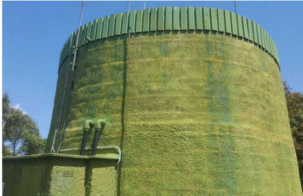
Figura 25 - Exterior Dipòsit de Can Regàs
