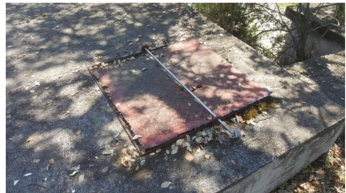
Figura 12 - Exterior Dipòsit Can Piu.
