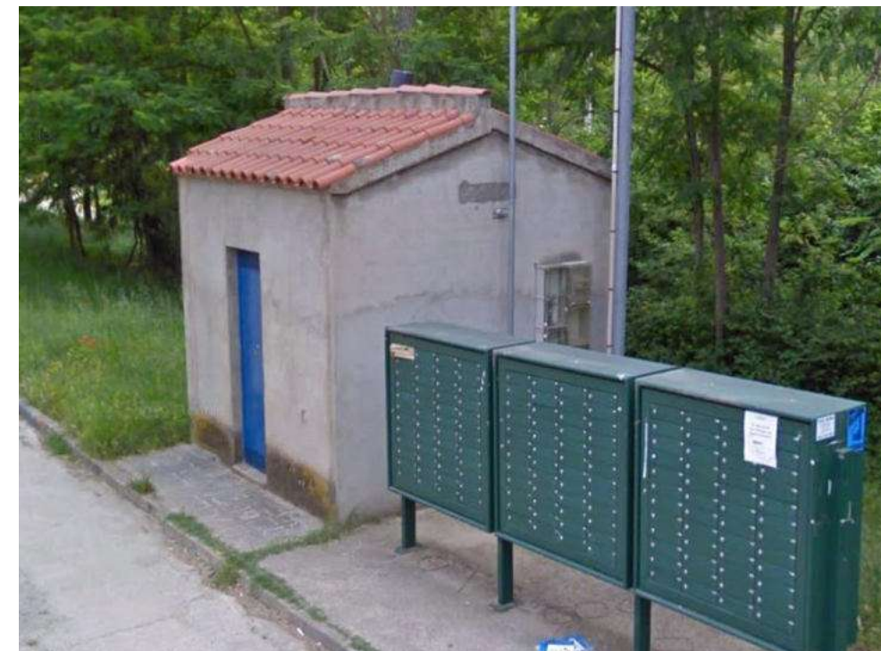
Figura 8 - Exterior del bombament de la urbanització de Riu Clar.
