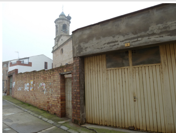
Línia de façana al C/ Major.
