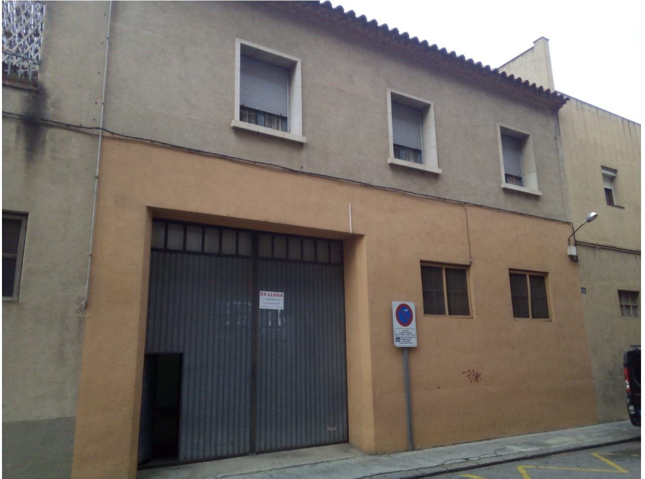
Estat actual façana carrer Nord número 23
