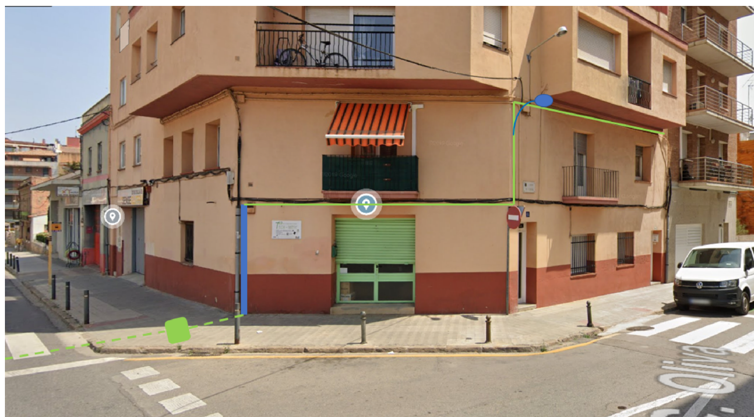
MUNTANT I PUNT DE LLUM CARRER OLIVA 63 - CREUAMENT AMB TORRAS I BAGES
