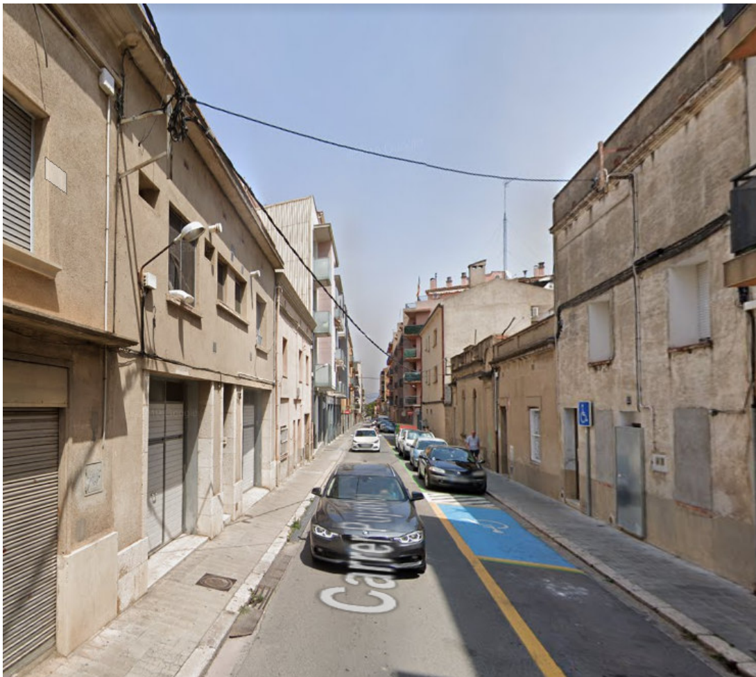
Figura 3 – Sector carrer Pujades – tipologia punts de llum existents
