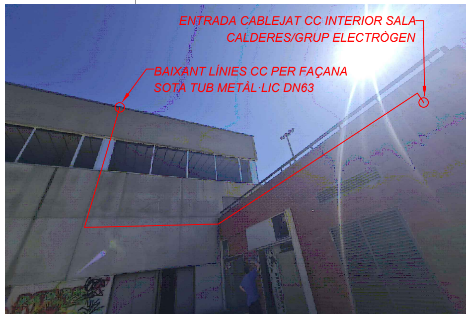
RECORREGUT CABLEJAT CC DE COBERTA FINS A SALA DE CALDERES / GRUP ELECTRÒGEN
