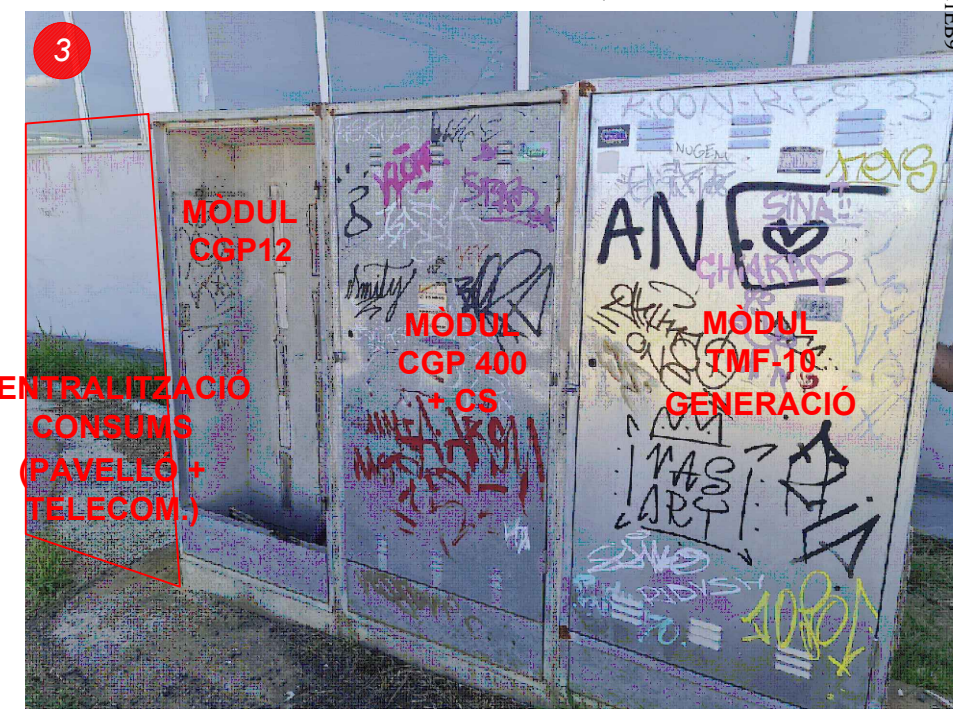
NOVA DISTRIBUCIÓ D'EQUIPS A L'ESCOMESA DEL PAVELLÓ, INCLOENT NOVA UBICACIÓ DE L'ESCOMESA DE CONSUM DEL PROPÍ PAVELLÓ JUNTAMENT AMB L'ESCOMESA DE CONSUM DE TELECOMUNICACIONS, I UBICACIONS PROPOSADAES PER AL NOU MÒDUL DE CGP-12 I PER AL NOU MÒDUL D'ESCOMESA PER A L'EQUIP DE COMPTATGE DE L'ENERGIA NETA GENERADA. CONNEXIONS SEGONS ESQUEMA D'EMPRESA DISTRIBUIDORA
