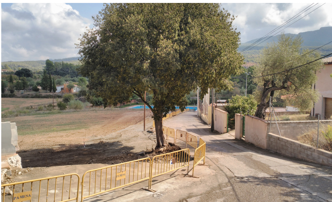
Obres en marxa al carrer Llaberia.
