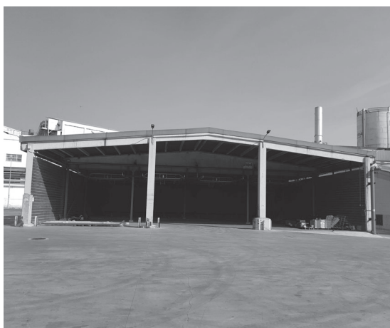
Foto 1: Nave almacén de biomasa
