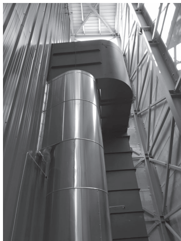
Fig.9 Precaentador de aire
