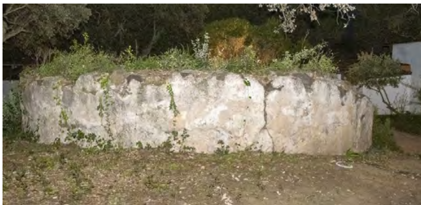
Figura 199. Imatge Torre de can Colom – 1218. Font: Inventari Patrimoni Arquitectònic Gencat.
