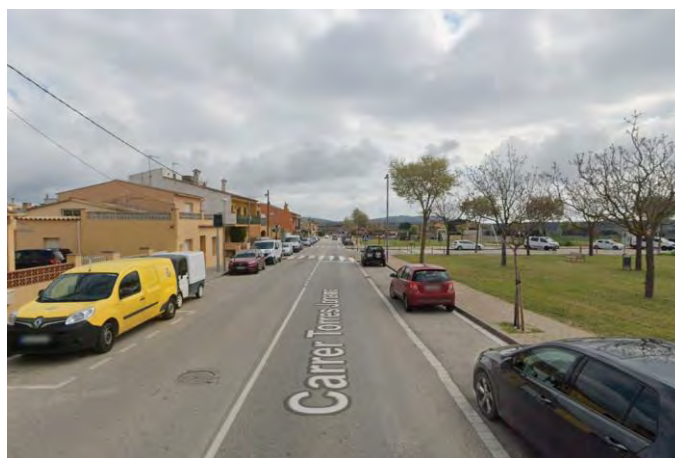
Figura 268. Carrer de Torres Jonama, en el terme municipal de Mont-ras.
