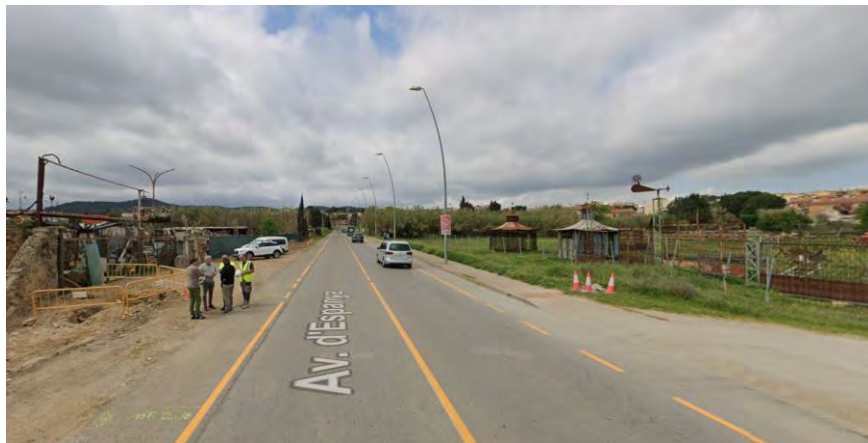
Figura 255. Obres d'urbanització de l'Av. d'Espanya. Tram adjacent al SUD 1.14 i SUD 1.15.
