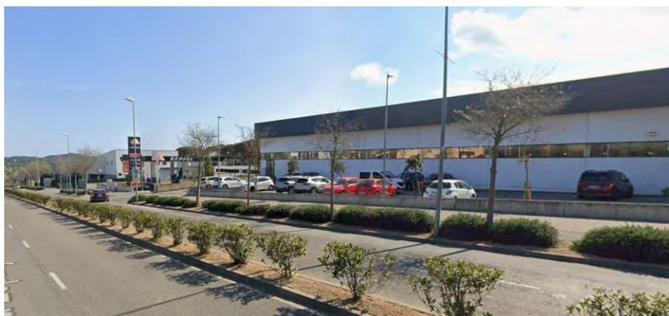
Figura 256. Imatge de l'estat actual del sòl urbà. Av. d'Espanya.
