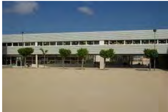
Figura 209. Escola Torres Jonama. Imatge del web del propi centre.
