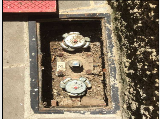
IMATGE INTERIOR ARQUETA
