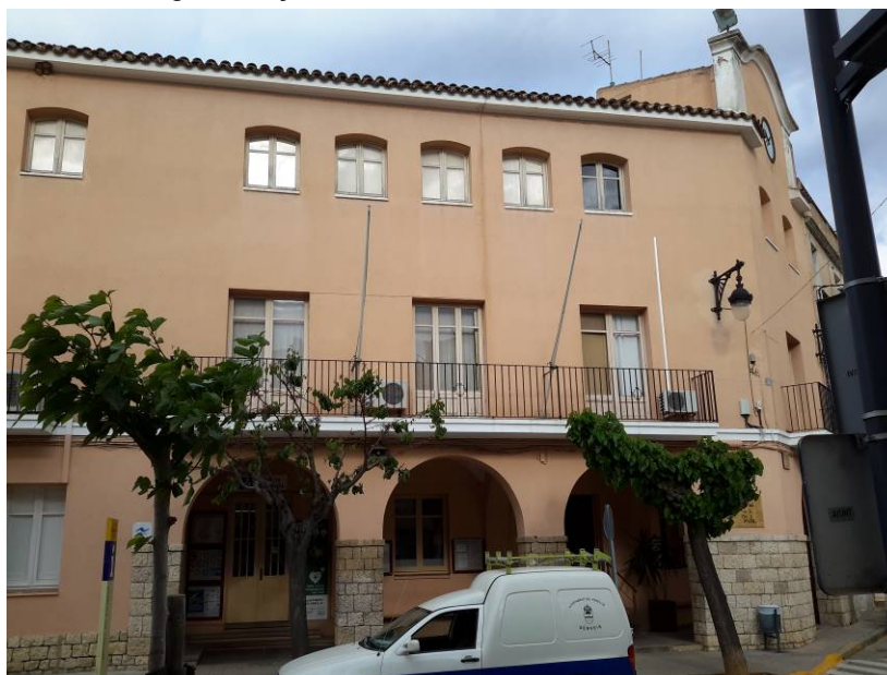
Imatge 2. Façana Sud-Est i cantonada de l'edifici.
