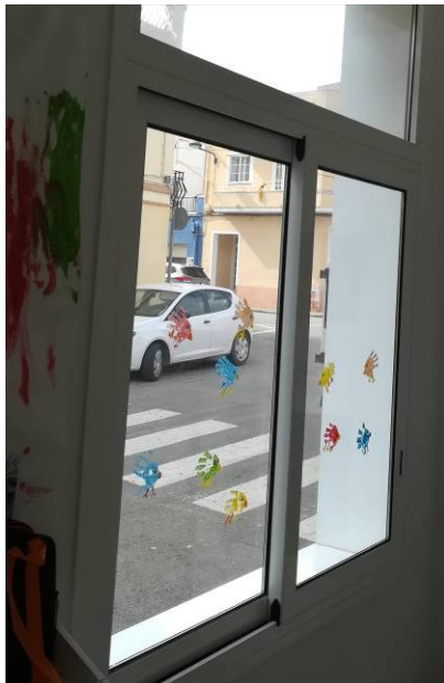
Imatge 10. Finestra d'alumini amb doble vidre.
