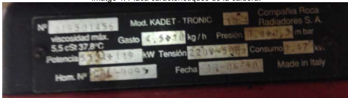
Imatge 4. Placa característiques de la caldera.
