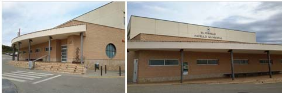
Imatge 2. Façana Nord.
