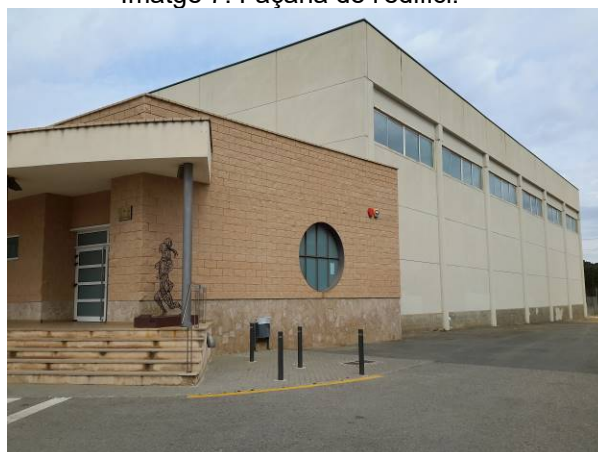
Imatge 7. Façana de l'edifici.
