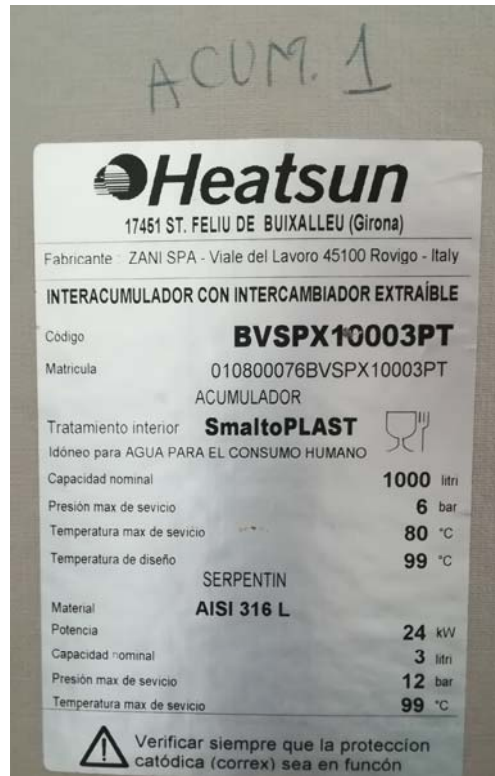
Imatge 5 i 6. Caldera del gimnàs i característiques de l'acumulador dels panells termosolars.
