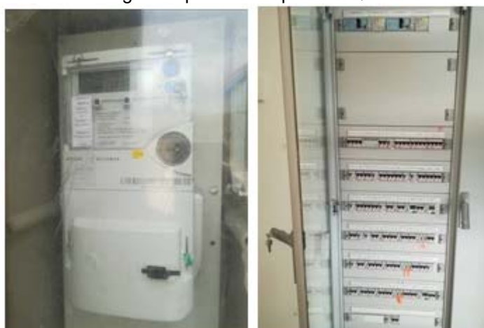
Imatge 8. Tipus de comptador i QGBT.
