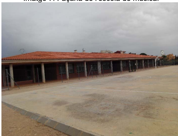
Imatge 7. Façana de l'escola de música.
