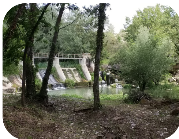
Presa de derivació del canal industrial del Guixaró.
