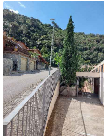
2. LATERAL EST EDIFICI
