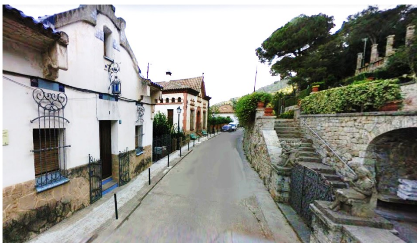
Carrer Mossèn Jacint Verdaguer amb edificacions unifamiliars
