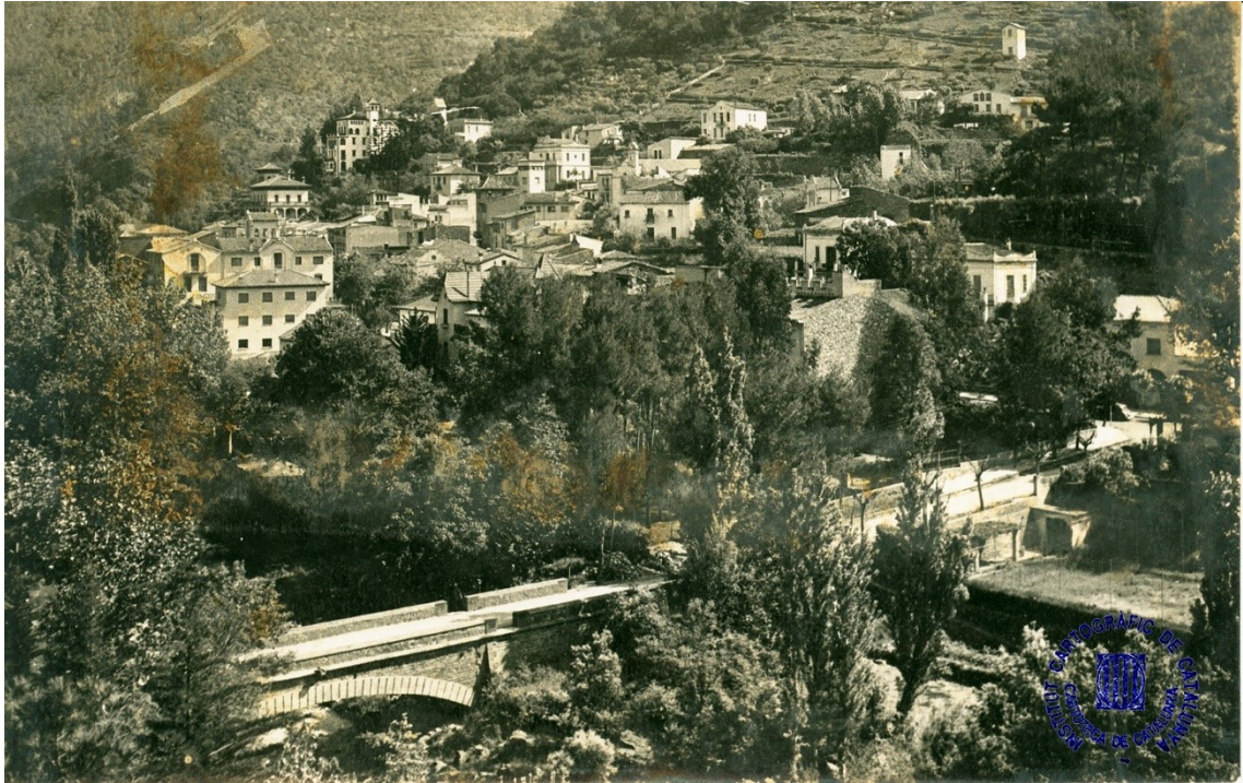
Fotografia Fons Pau Vil. L'edificació és anterior a les NNSS'81
