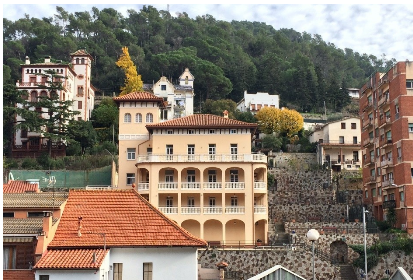
Fotografia actual de la façana oest (principal)
