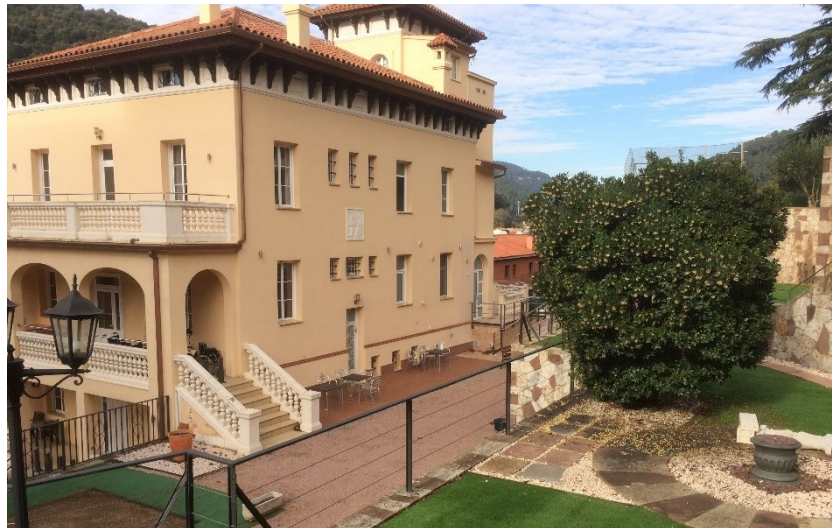
Fotografia actual de la façana oest (principal)
