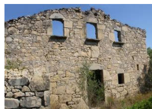
Vista de l'única façana que es conserva
