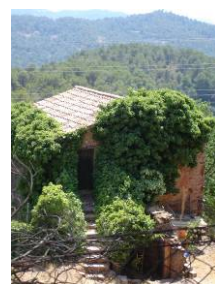
Vista nord de la casa de pedra
