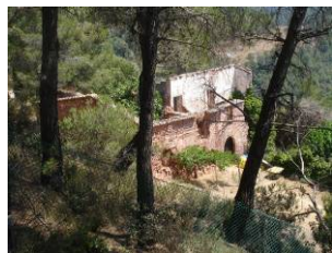
Vista dels diferents coberts adossats
