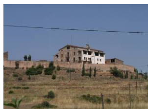
Vista est del conjunt, des del camí d'accés
