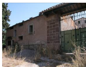
Vista de l'accés a l'era de la casa
