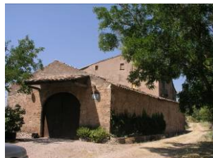
Façana est on hi ha l'accés principal
