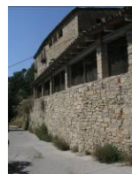
Façana sud de pedra
