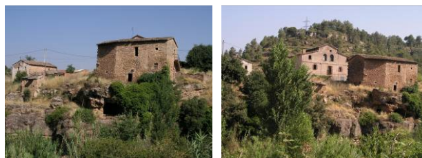
Vista de les façanes sud, des del camí de cal Ganàpia cap el conjunt de volums
