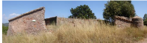
Vista oest de tot el conjunt de la masia amb els seus coberta adossats.
