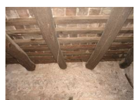
Estructura de fusta interior de la masia
