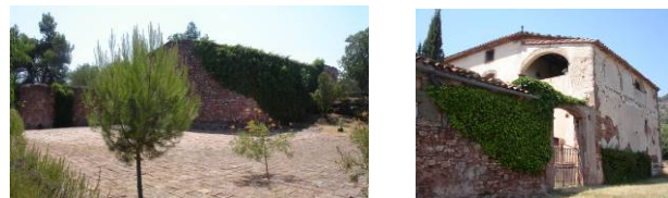
Vista de la façana est del cobert aïllat a la casa
