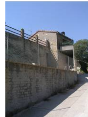
Façana est des del camí
