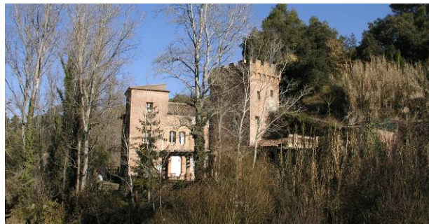
Vista del conjunt de les edificacions i la seva situació respecte la topografia.
