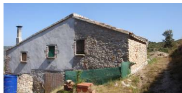
Vista de la façana sud de la casa
