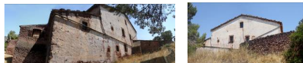
Vista de la façana oest on es veuen els volums de pedra adossats, amb teula àrab
