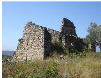
Vista general de la casa i de la seva situació respecte la topografia i l'entorn.
