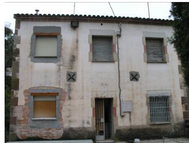
Vista de la façana principal amb dos tirants com a reforç estructural (de la façana al forjat)
