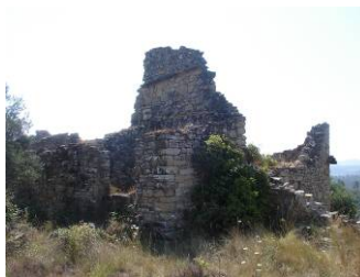
Vista general de la casa des de la façana principal i els cossos adossats
