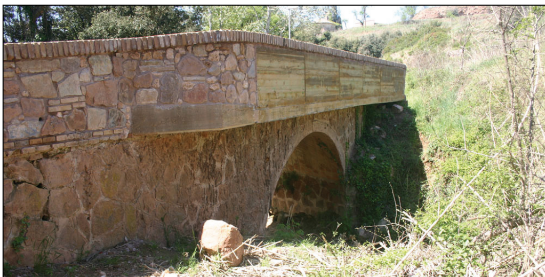
Fig.17. Pont sobre el torrent de la Font d'en Sala (Punt F1).
