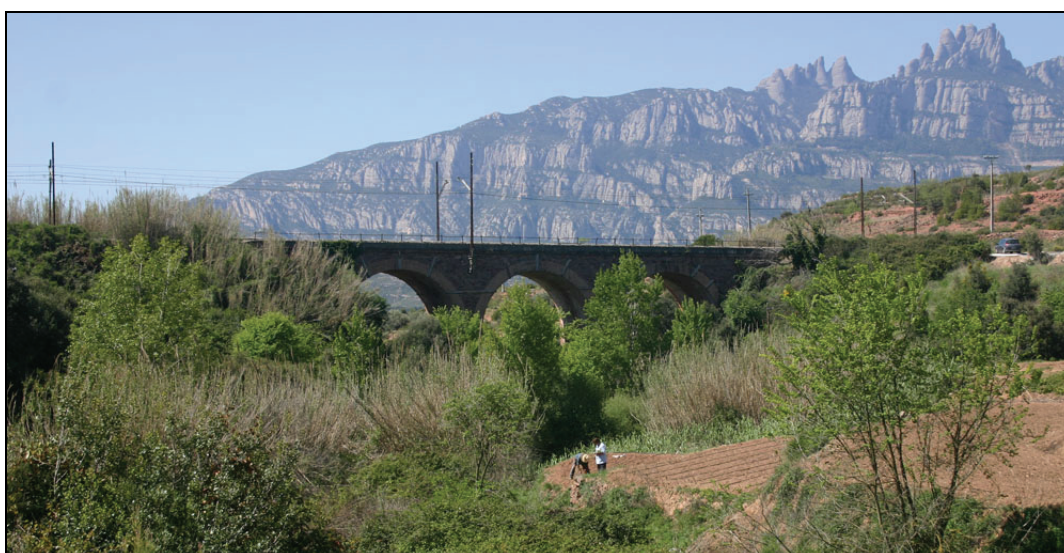
Fig.20. Pont del Ferrocarril de Barcelona a Manresa i Lleida sobre la riera de Sanana (Punt S2).
