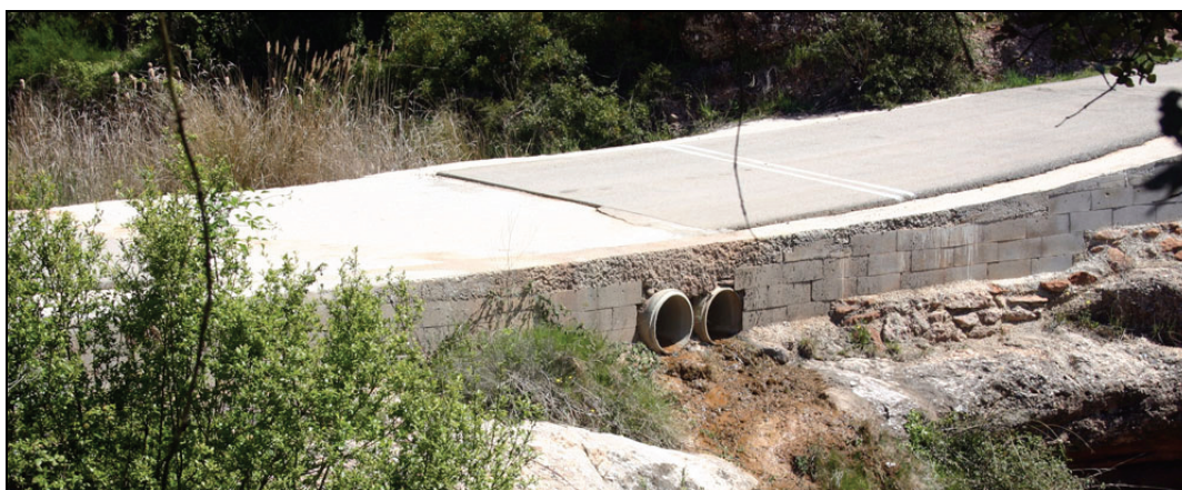
Fig.18. Gual sobre el torrent de l'Esbarzer (Punt E1).
