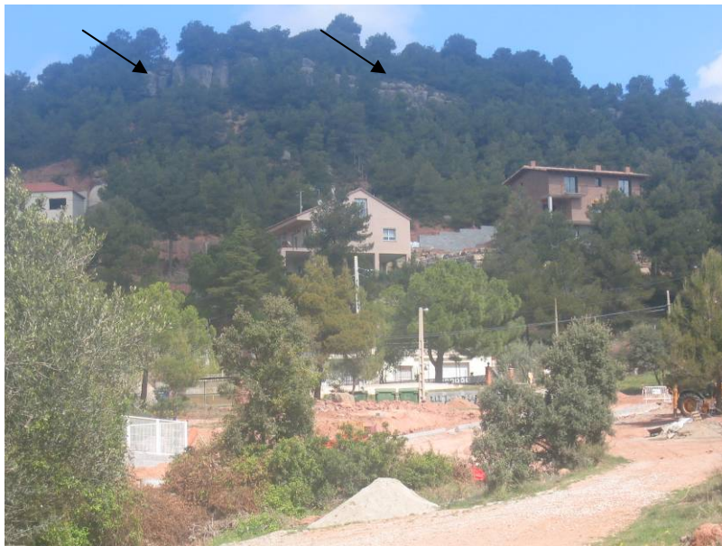
Fotografia 3: Aspecte general del vessant del Llom dels Pivers i les Serres. Observar com destaca en el terreny la cinglera conglomeràtica d'on procedeixen la major part dels blocs despresos.
