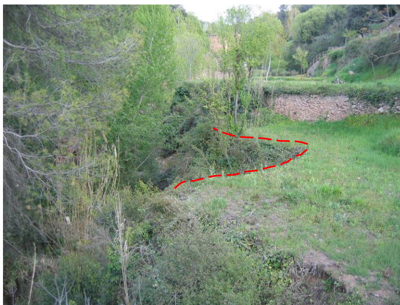
Fotografia 2: Exemple d'inestabilització superficial que afecta el marge esquerre de la riera de Rellinars al seu pas per la població de Rellinars.
