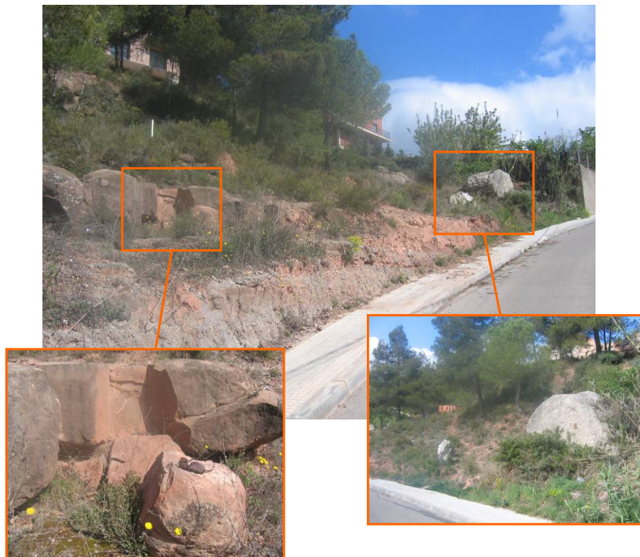
Fotografia 5: Vista d'un dels sectors inferiors del vessant del Llom dels Pivers, situat al peu de la Punta Blanca, on s'observa un antic bloc caigut procedent de la cinglera conglomeràtica situada a mig vessant (veure fotografia 3), d'uns 6 m 3 de volum, així com un petit despreniment recent quasi sense desplaçament que afecta un estrat de gres.
